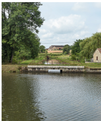
Vue de la rigole. Phot. Pierre-Marie Barbe-Richaud IVR26_20175800126NUC2A
