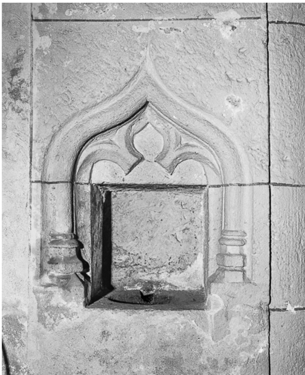
Lavabo de la chapelle latérale gauche.
