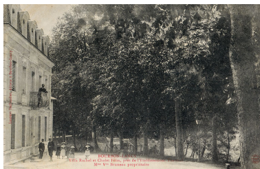
Vue ancienne. Autr. auteur inconnu IVR26_20207100067NUC4A
