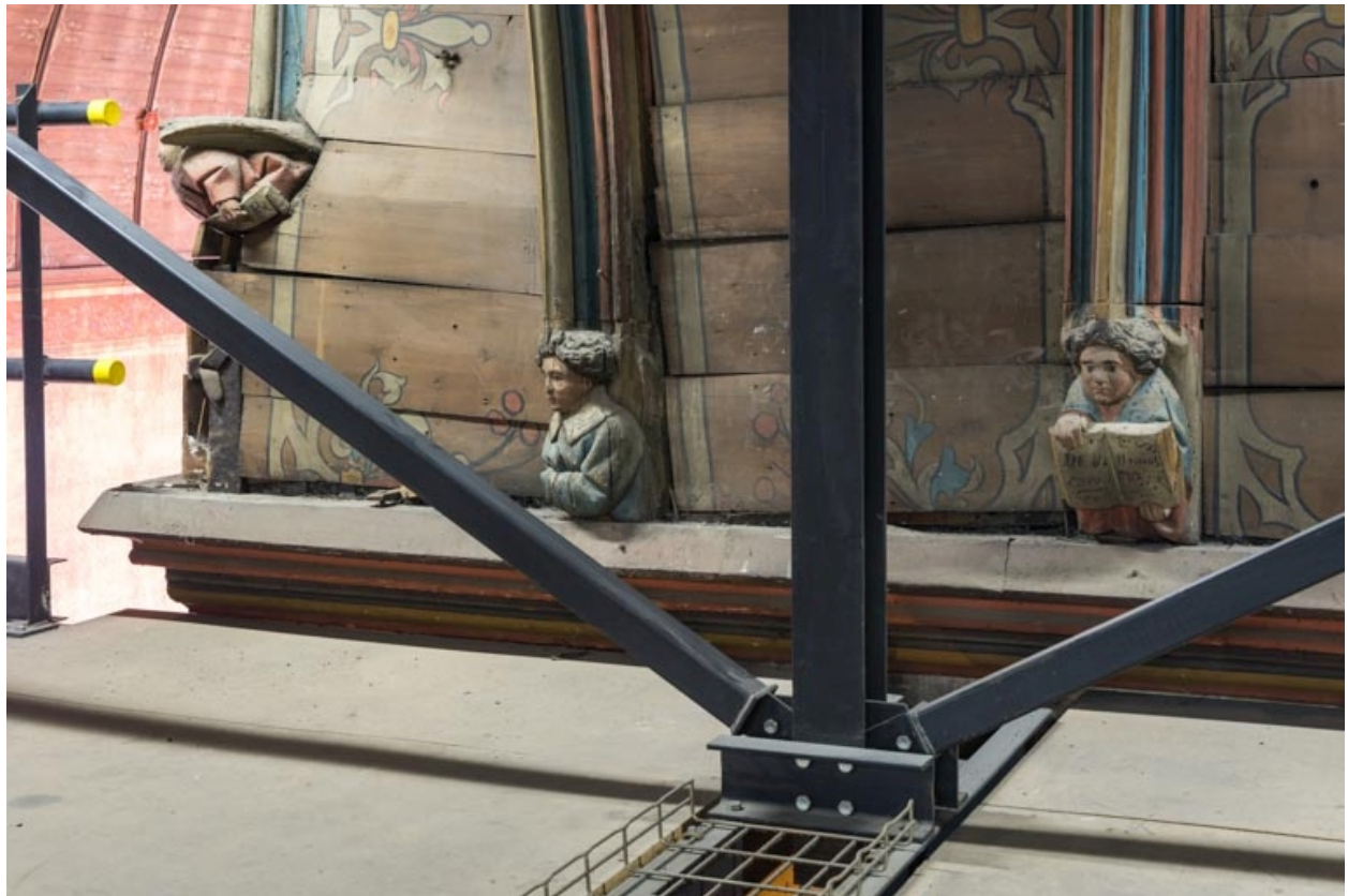
Angle nord-ouest, mur ouest : deux anges.
