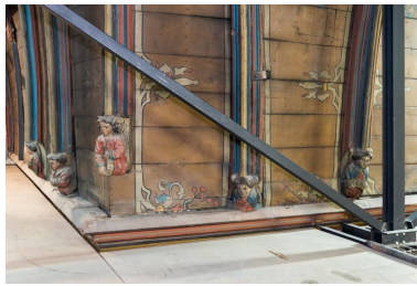
Angle sud-est : cinq anges. Phot. Pierre-Marie Barbe-Richaud IVR26_20222100431NUC4A
