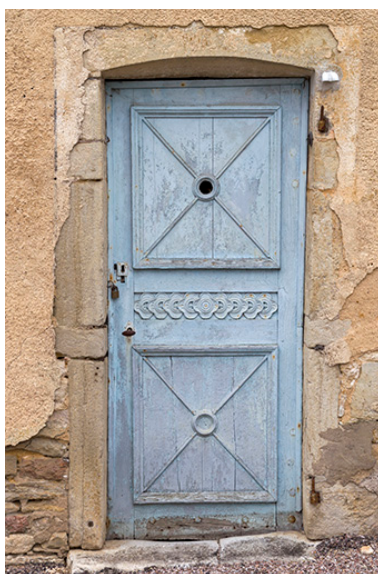
Ferme 5 rue du Château : porte du logis.
