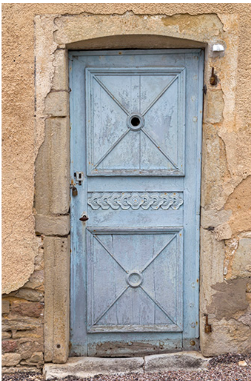
Ferme 5 rue du Château : porte du logis.
