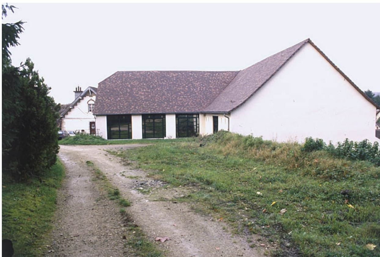
Ancienne halle à charbon depuis l'est.
