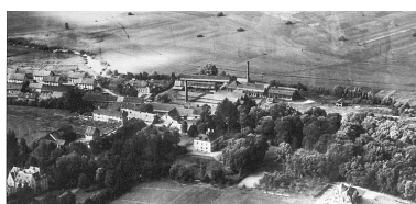
Vue aérienne vers 1960. Phot. Jérôme Mongreville IVR43_20029000039X
