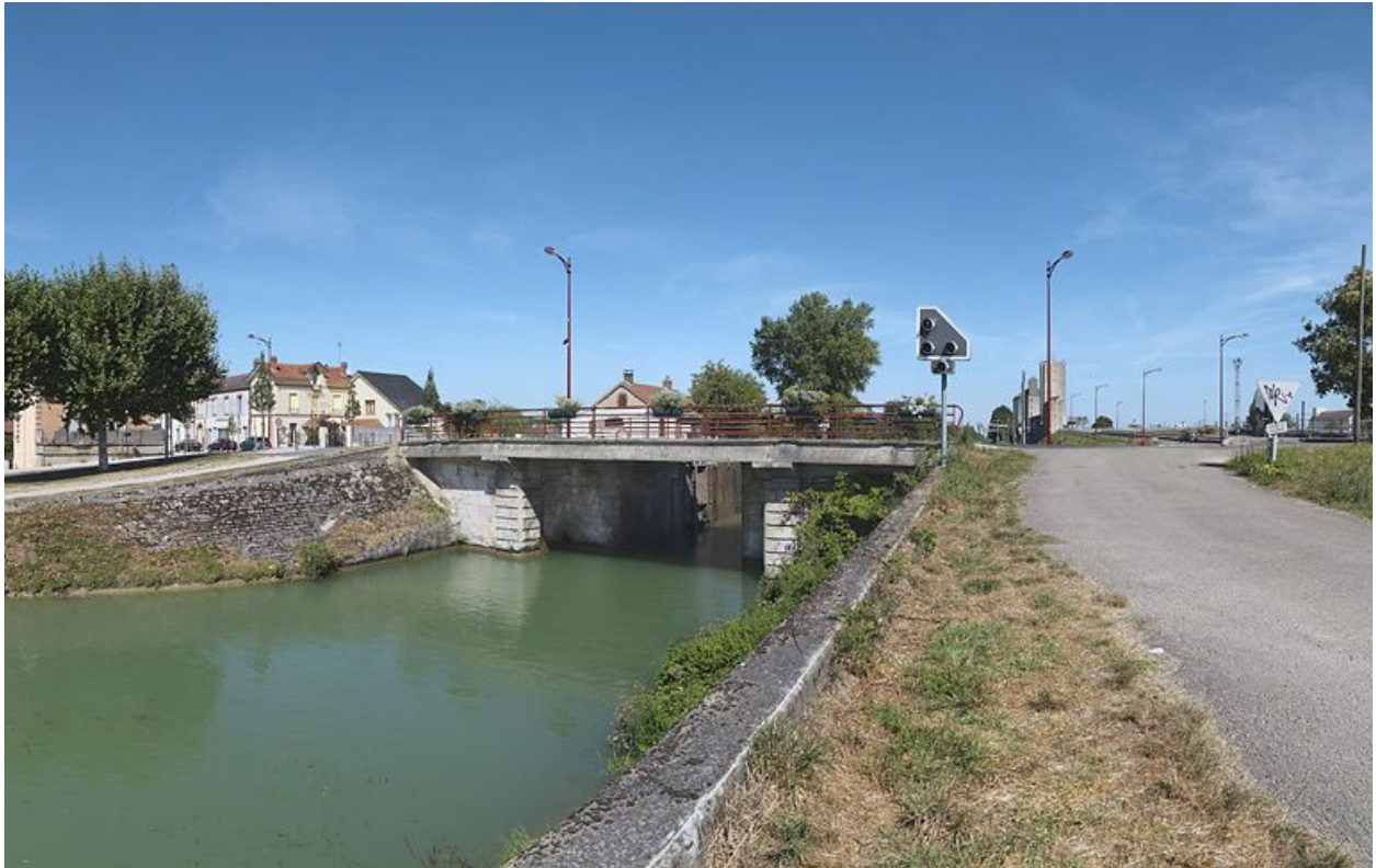
Pont vu d'aval.
