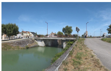
Pont vu d'aval.
