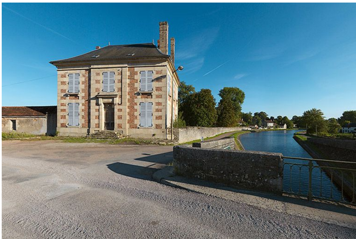
Vue de face. A droite le canal.
