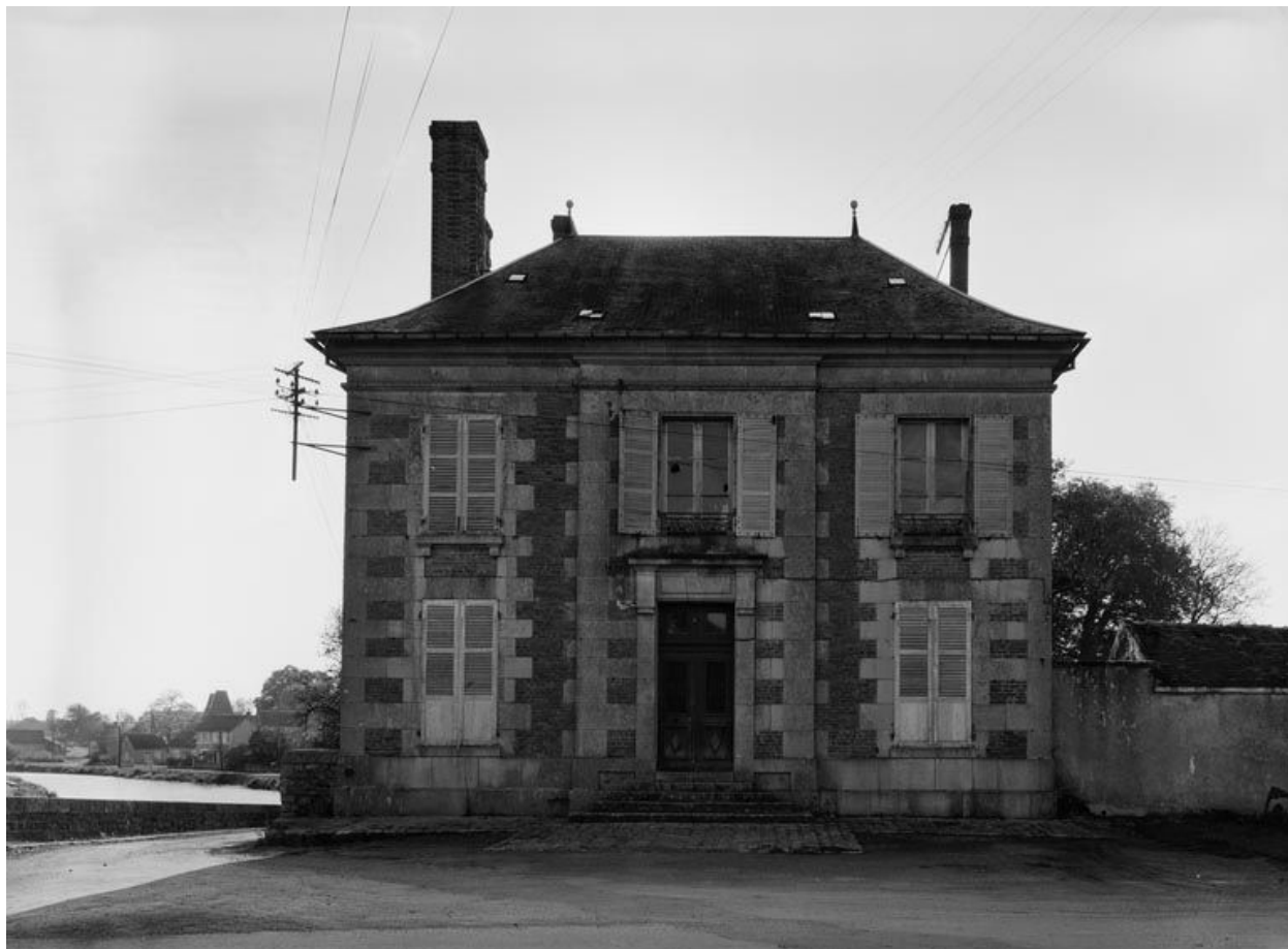
Vue de la façade principale (en 1975).
