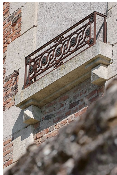
Détail du garde-corps.
