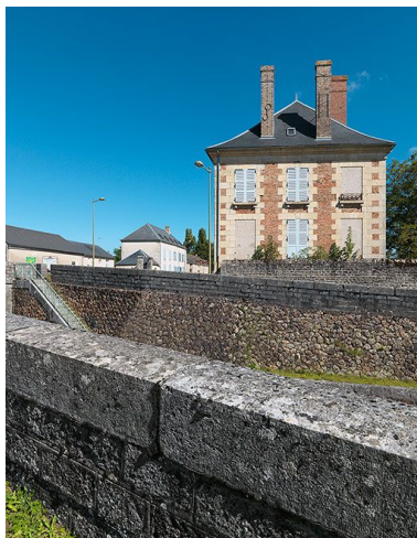
Façade latérale sud.
