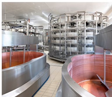
Installation de pressage, vue depuis les cuves. Phot. Sonia Dourlot IVR43_20192500954NUC4A
