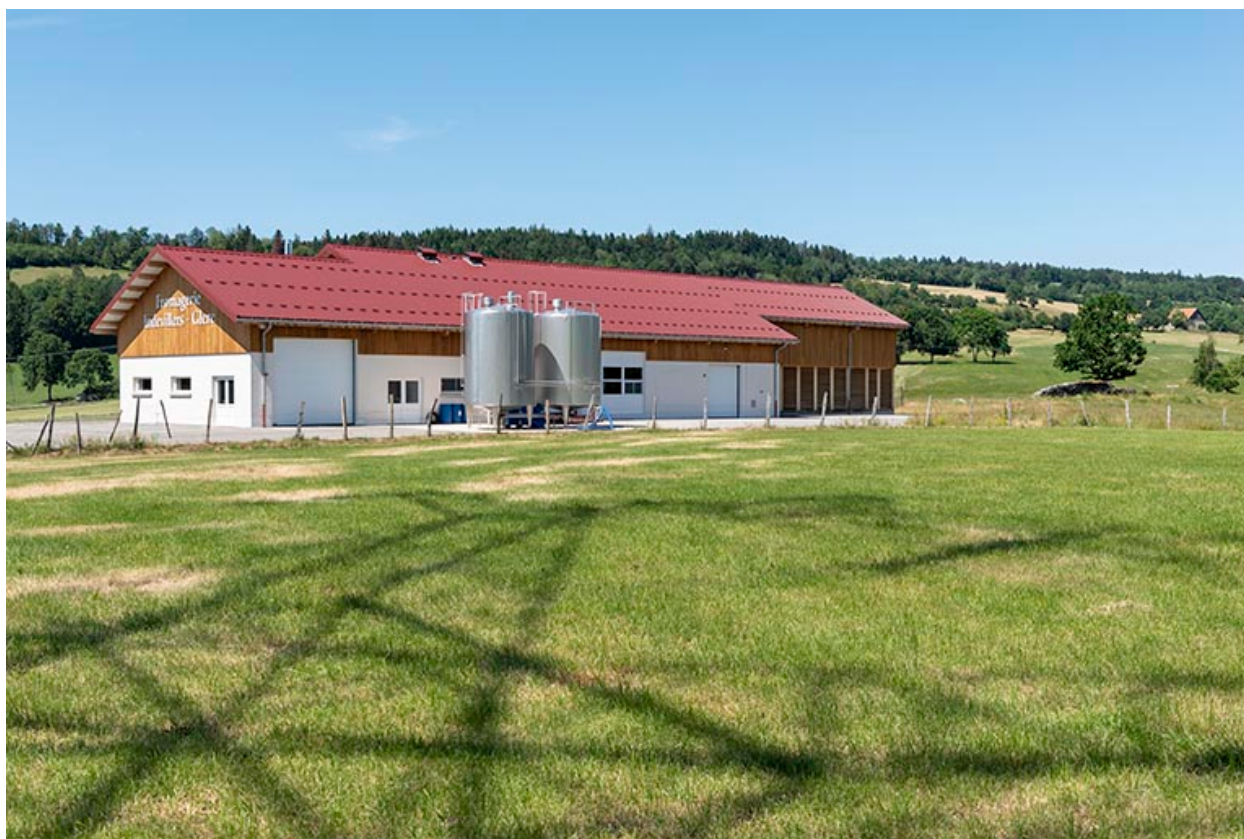
Façades postérieure et latérale droite.
