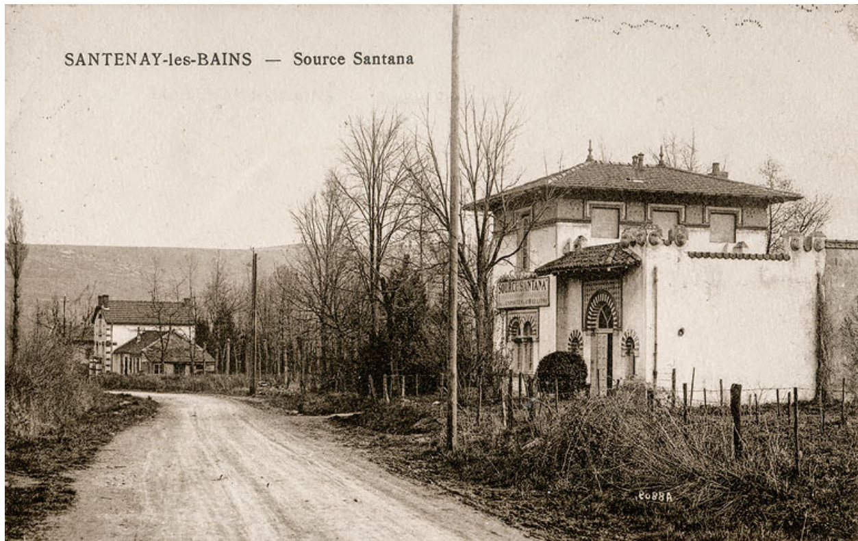
Vue ancienne, depuis le nord-ouest.
