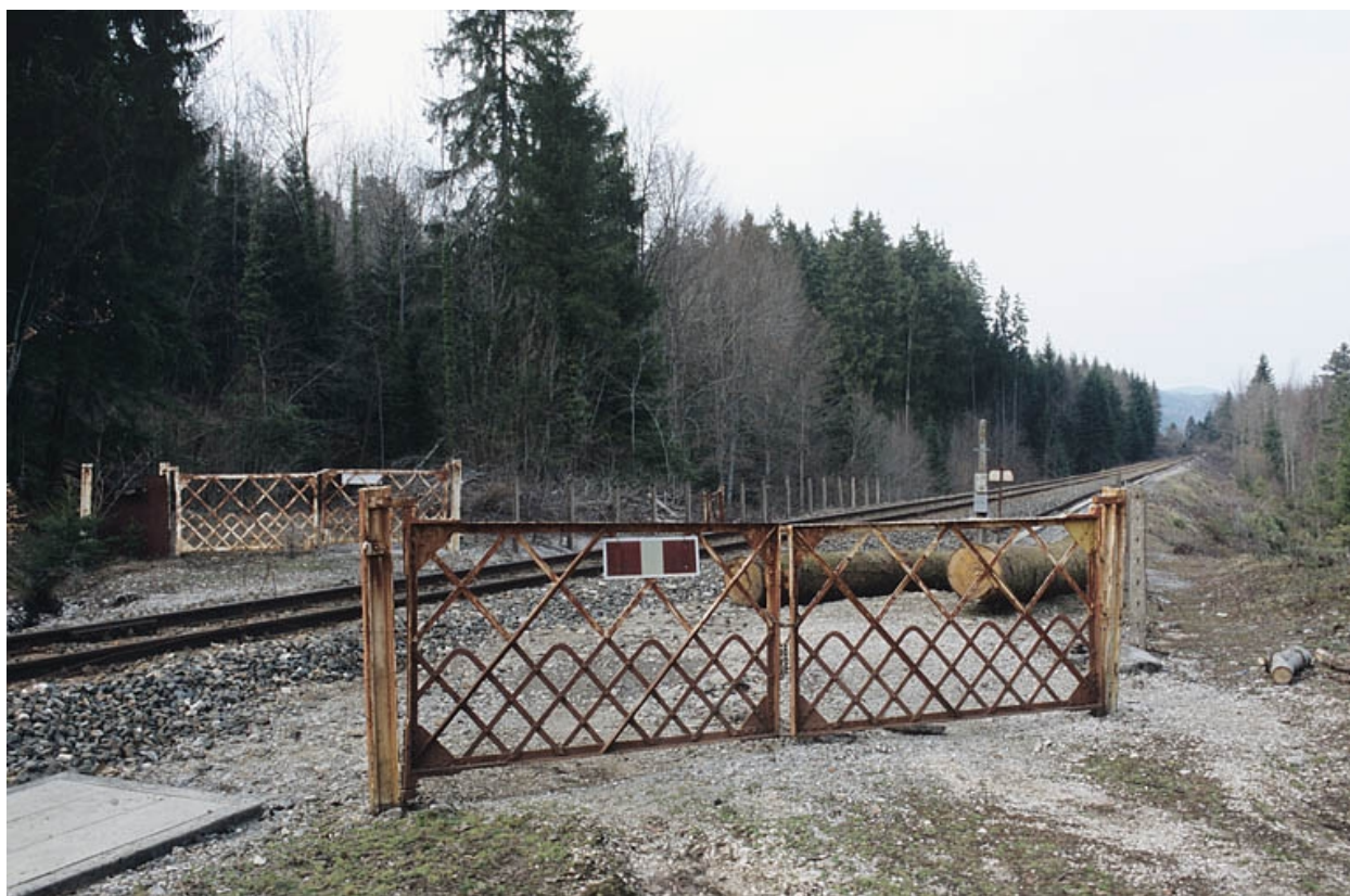
Vue d'ensemble, depuis le sud.
