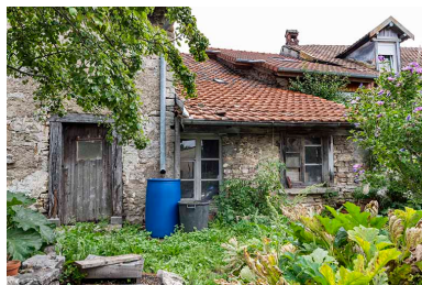
Forge : façade postérieure. Phot. Sonia Dourlot IVR43_20192501220NUC4A
