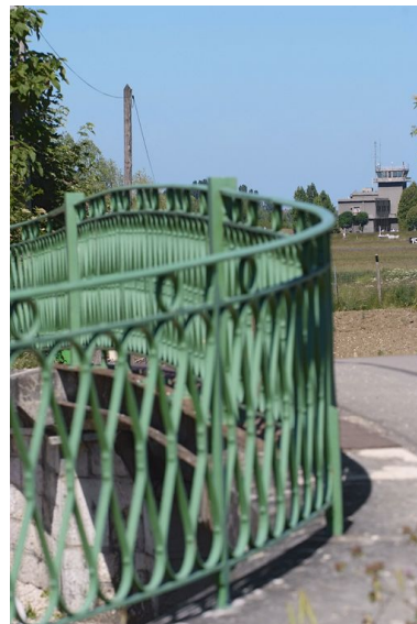
Détail du garde-corps en ferronnerie.
