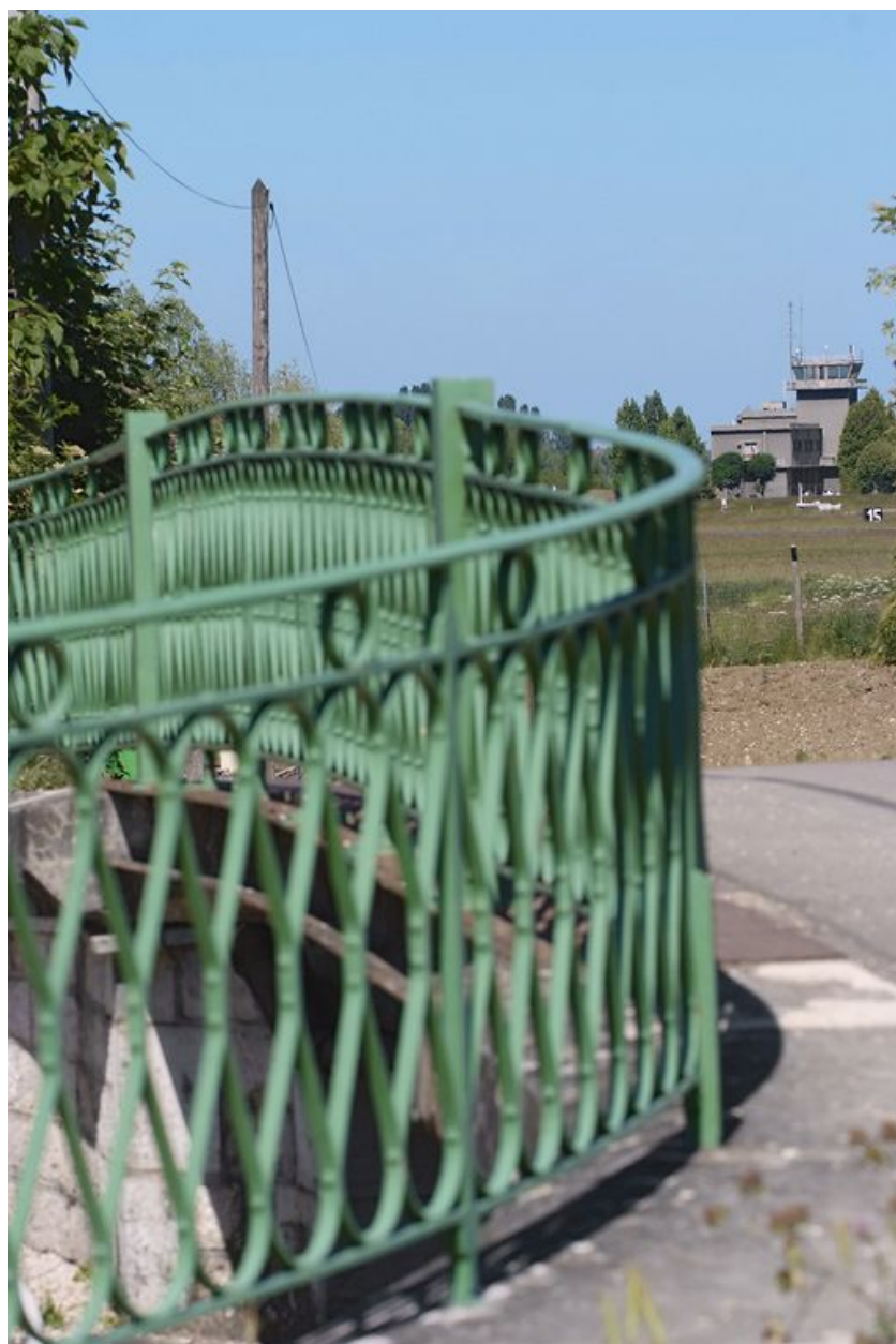
Détail du garde-corps en ferronnerie.
