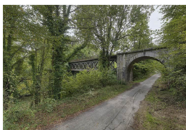
A Montchanin, le pont ferroviaire, avec une partie en maçonnerie enjambant le chemin de halage et une partie en métal enjambant le canal.
