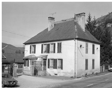
Ancienne conciergerie, en 1980. Phot. Yves Sancey IVR43_19802501416X
