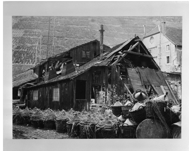
Atelier de "décaperie" du fil de fer, et stockage d'acide chlorydrique en bonbonnes, fotogr., s.n., s.d. [avant 1903]. Phot. D. Dominguez IVR43_19822500283V
