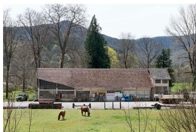
Atelier de mécanique. Phot. Jérôme Mongreville IVR43_20152501186NUC4A
