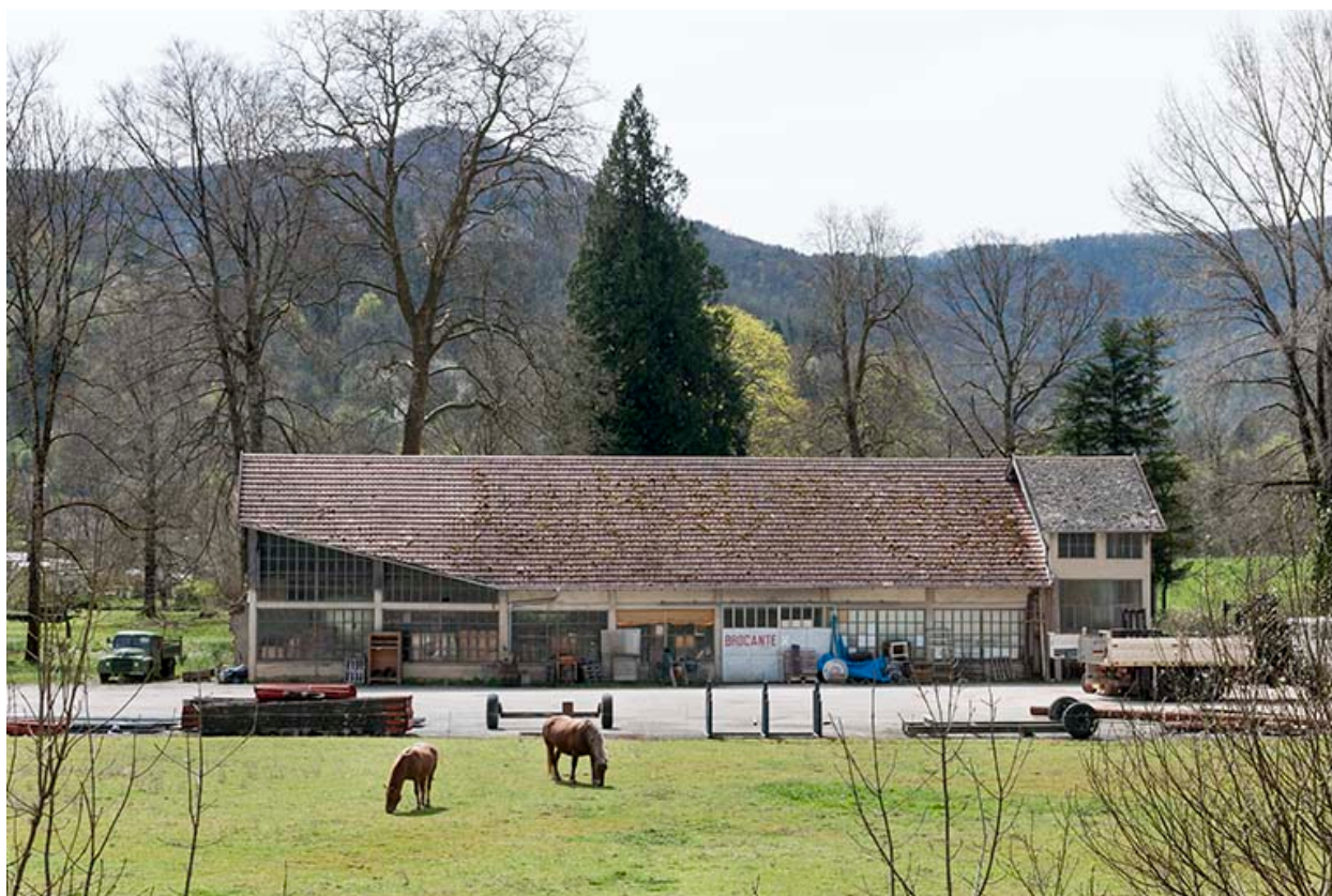
Atelier de mécanique.
