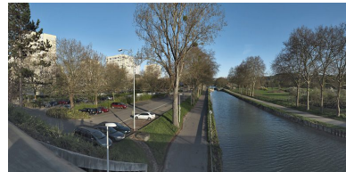
Vue d'ensemble depuis le canal.
