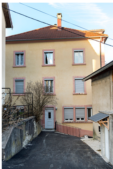
Façade latérale droite. Phot. Sonia Dourlot IVR43_20162501685NUC4A
