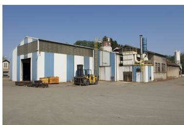
Le nouvel atelier de fonderie. Phot. Jérôme Mongreville IVR43_20067000485NUCA
