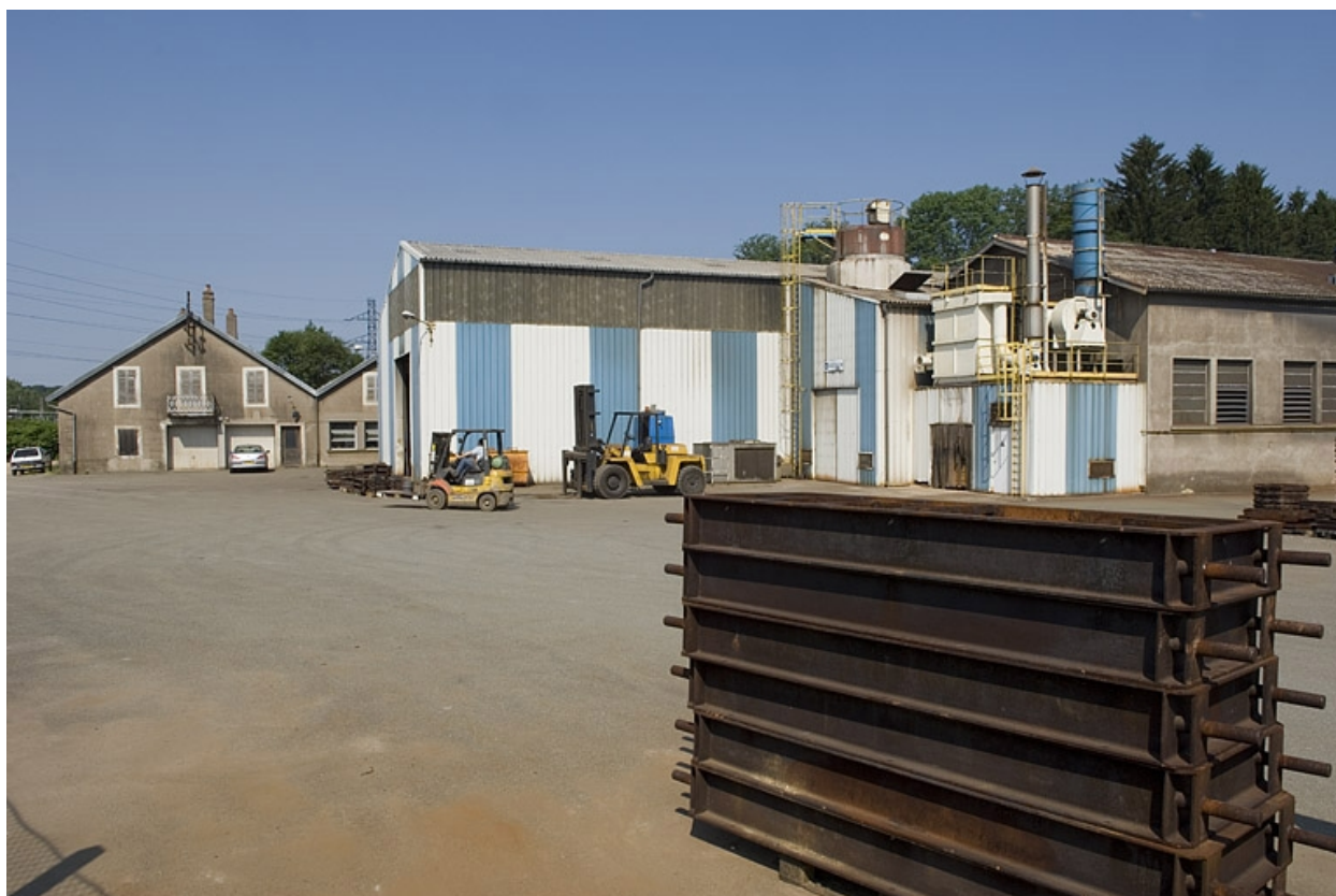
L'ancien et le nouvel atelier de fonderie.
