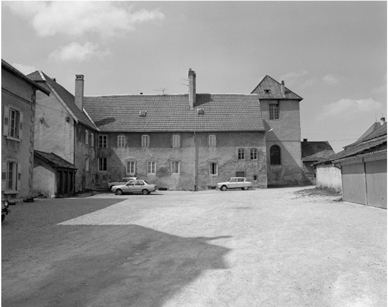
Façade extérieure d'un corps de bâtiment conventuel.
