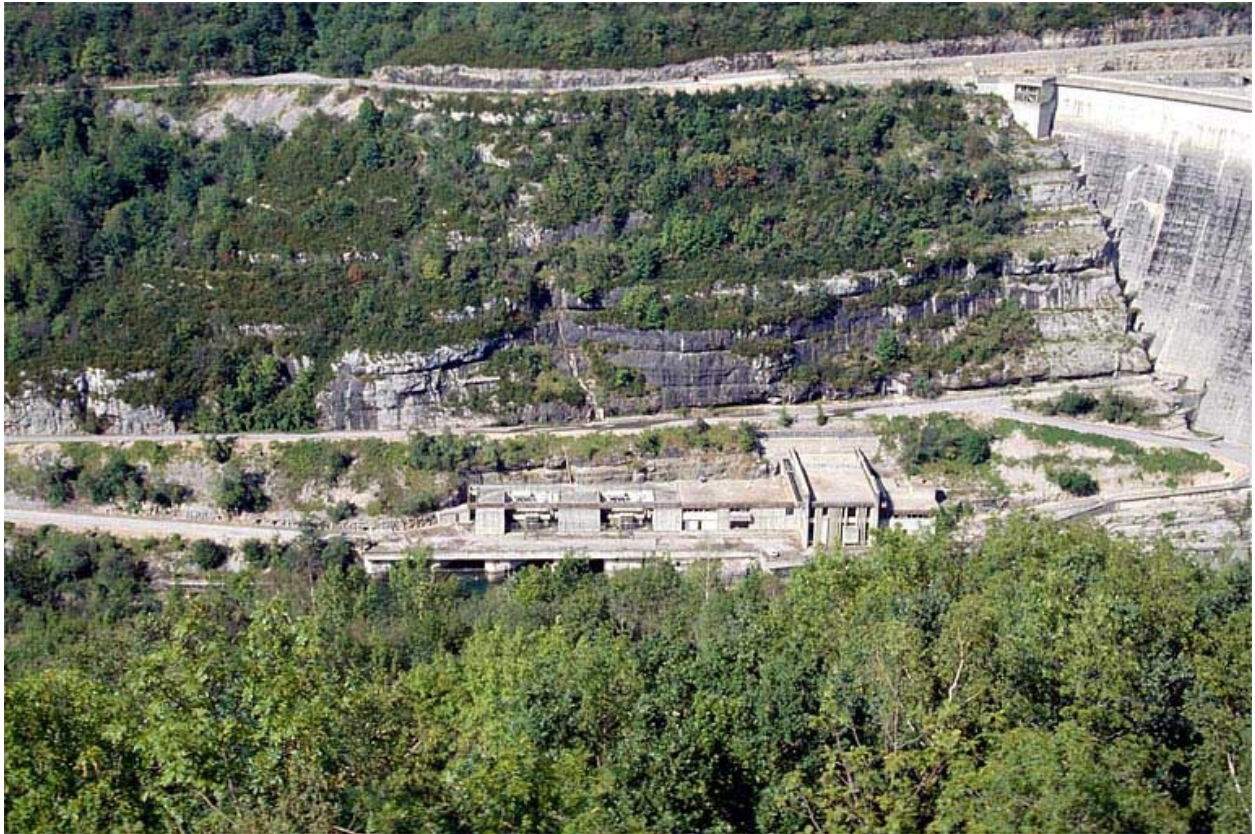
La centrale hydroélectrique.
