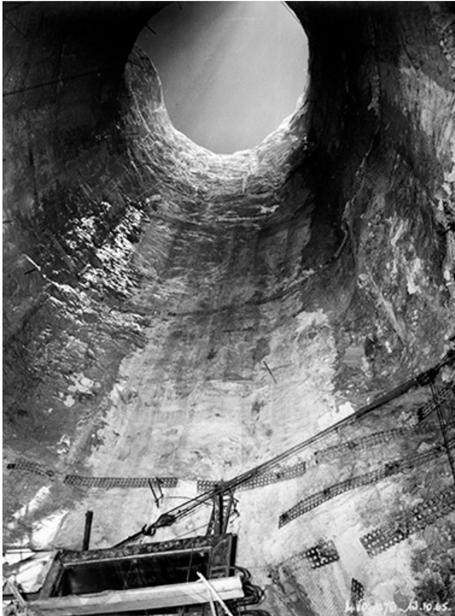
Puits 1-2, sommet entonnement 1.
