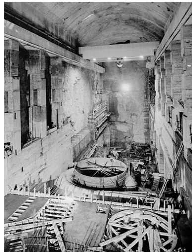
[Centrale. Vue intérieure et bâche du groupe II ou III]. Phot. Jérôme Mongreville, Autr. Studios Villeurbannais Monchanin et Périchon IVR43_19913900315X
