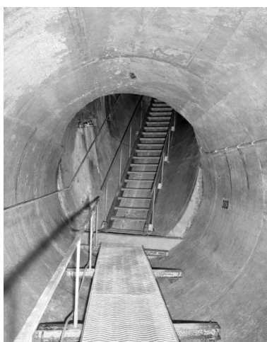
Extrémité inférieure de la "galerie de pied".
