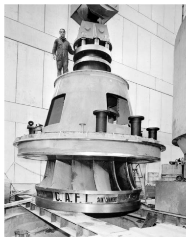
Roue turbine : support pivoterie en cours de montage. Phot. Jérôme Mongreville, Autr. Studios Villeurbannais Monchanin et Périchon IVR43_19913900320X
