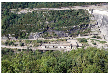
La centrale hydroélectrique. Phot. Jérôme Mongreville IVR43_19913900685ZA
