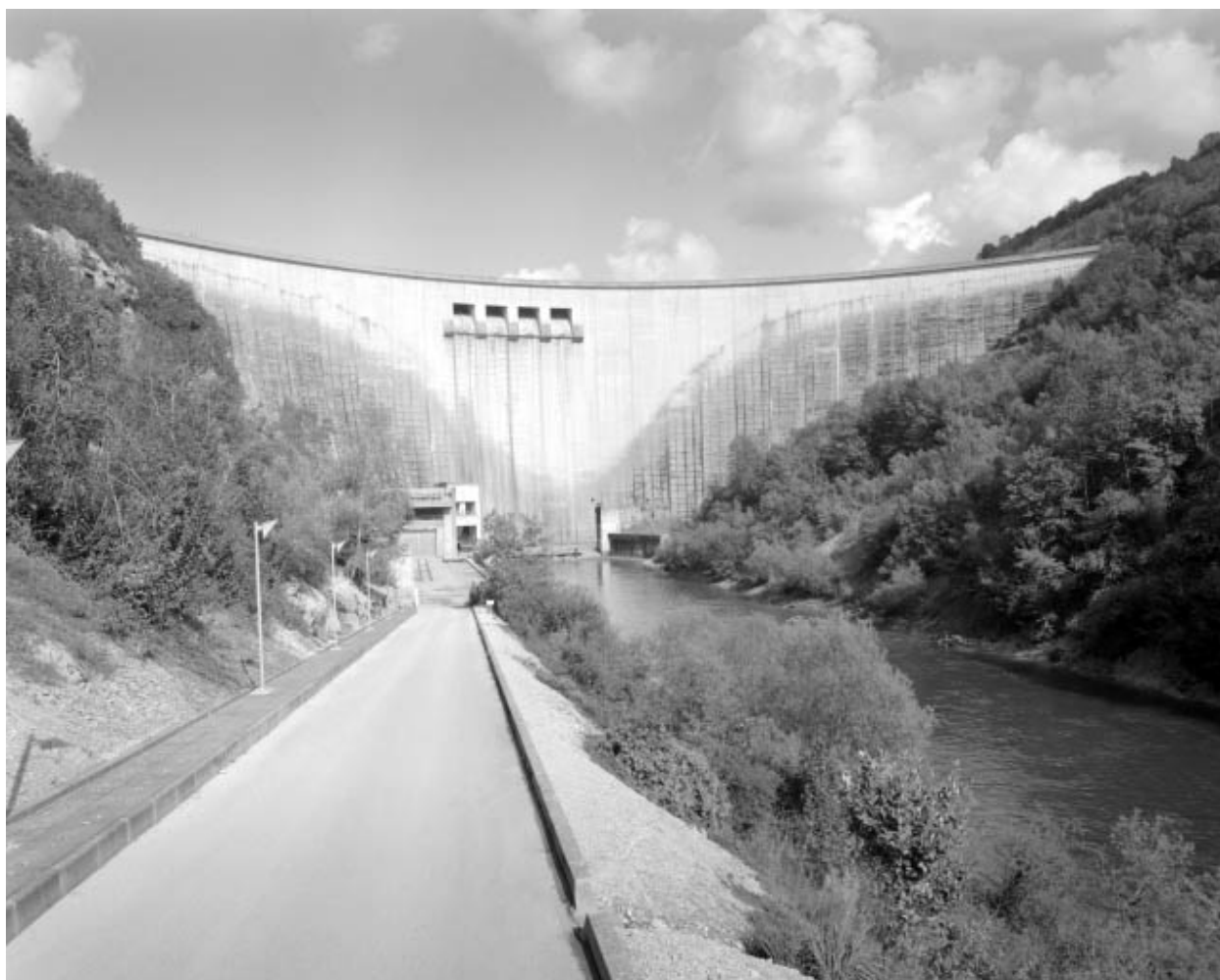
Le barrage, vu d'aval.
