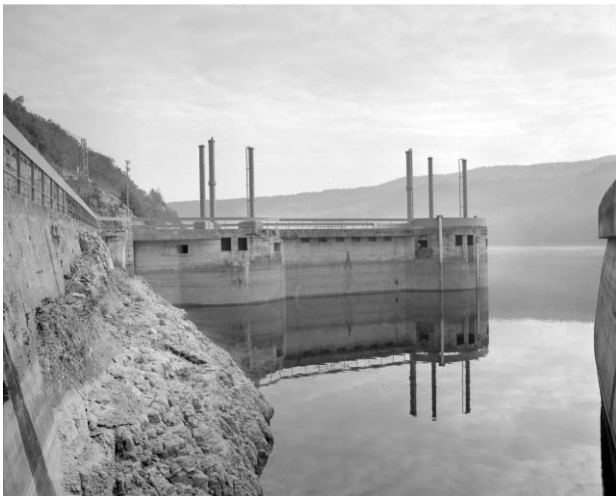
Tours de la prise d'eau.
