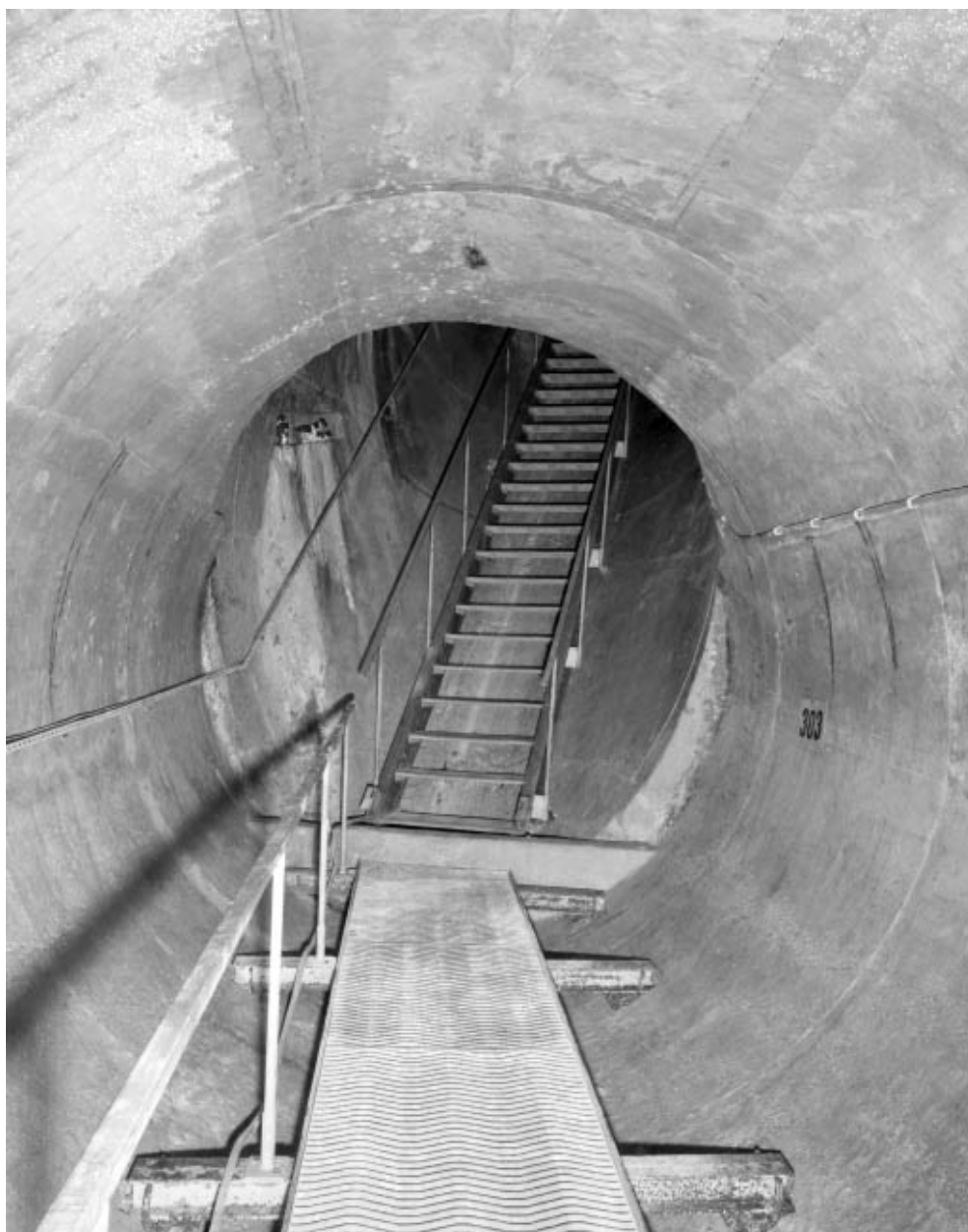
Extrémité inférieure de la "galerie de pied".
