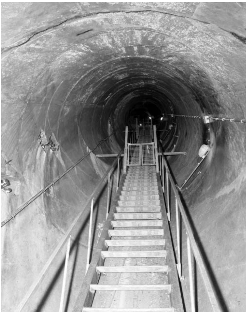
Galerie de pied".Galerie de circulation longitudinale qui descend jusqu'à la base du barrage.
