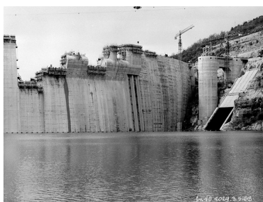
Barrage - Vue amont déversoir et prise d'eau. Phot. Jérôme Mongreville, Autr. Studios Villeurbannais Monchanin et Périchon IVR43_19913900319X
