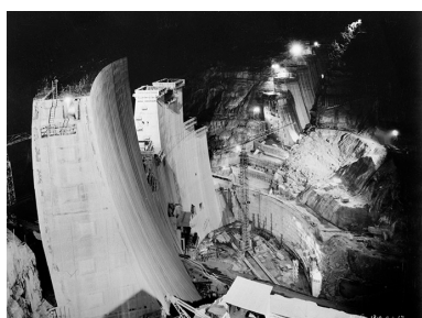
Barrage - Vue générale depuis R.D. aval des plots en cours de bétonnage (de nuit). Phot. Jérôme Mongreville, Autr. Studios Villeurbannais Monchanin et Périchon IVR43_19913900314X
