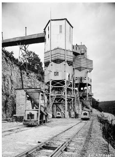
Tour à béton et silobus. Phot. Jérôme Mongreville, Autr. Studios Villeurbannais Monchanin et Périchon IVR43_19913900305X
