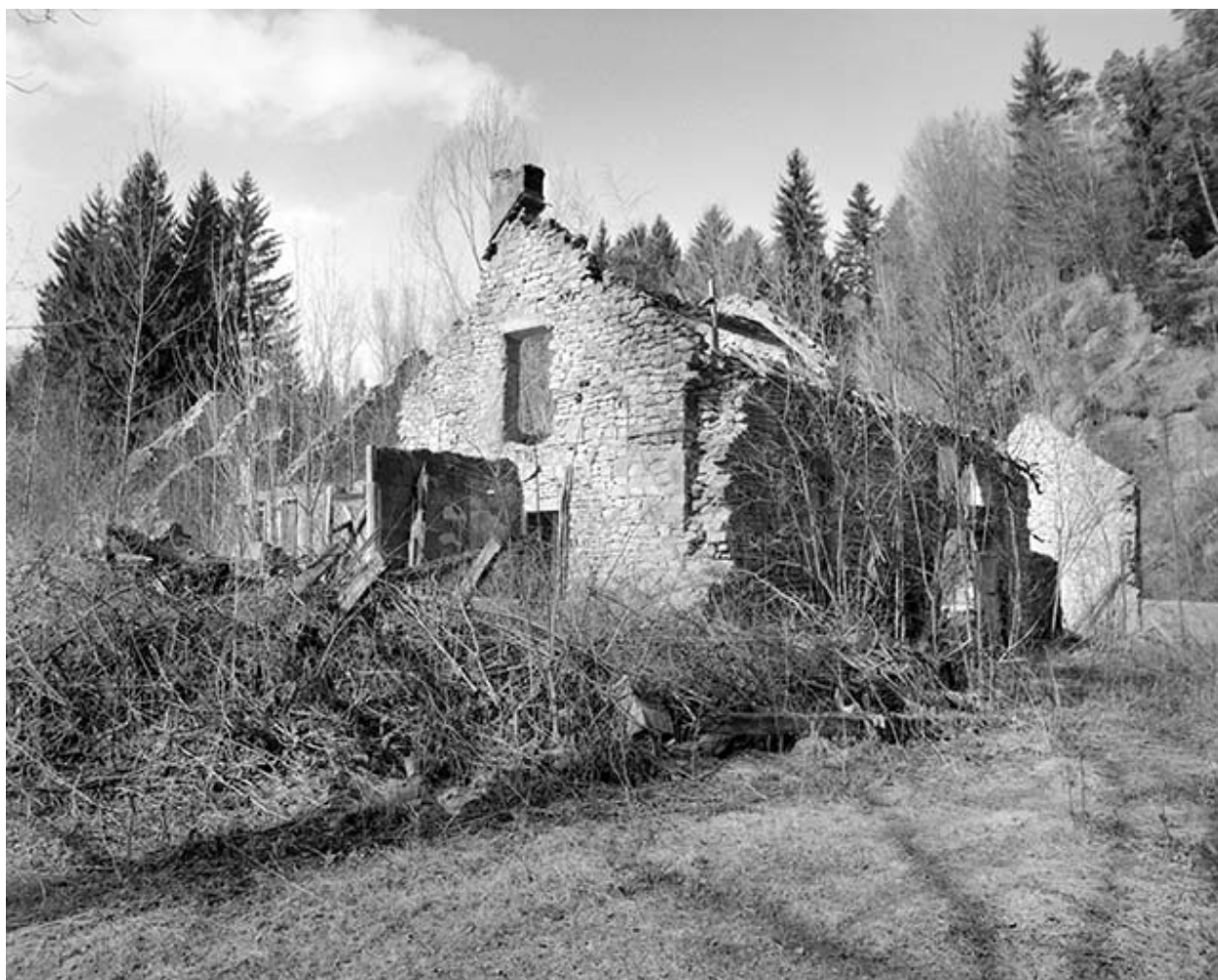
Aile sud du logement patronal.
