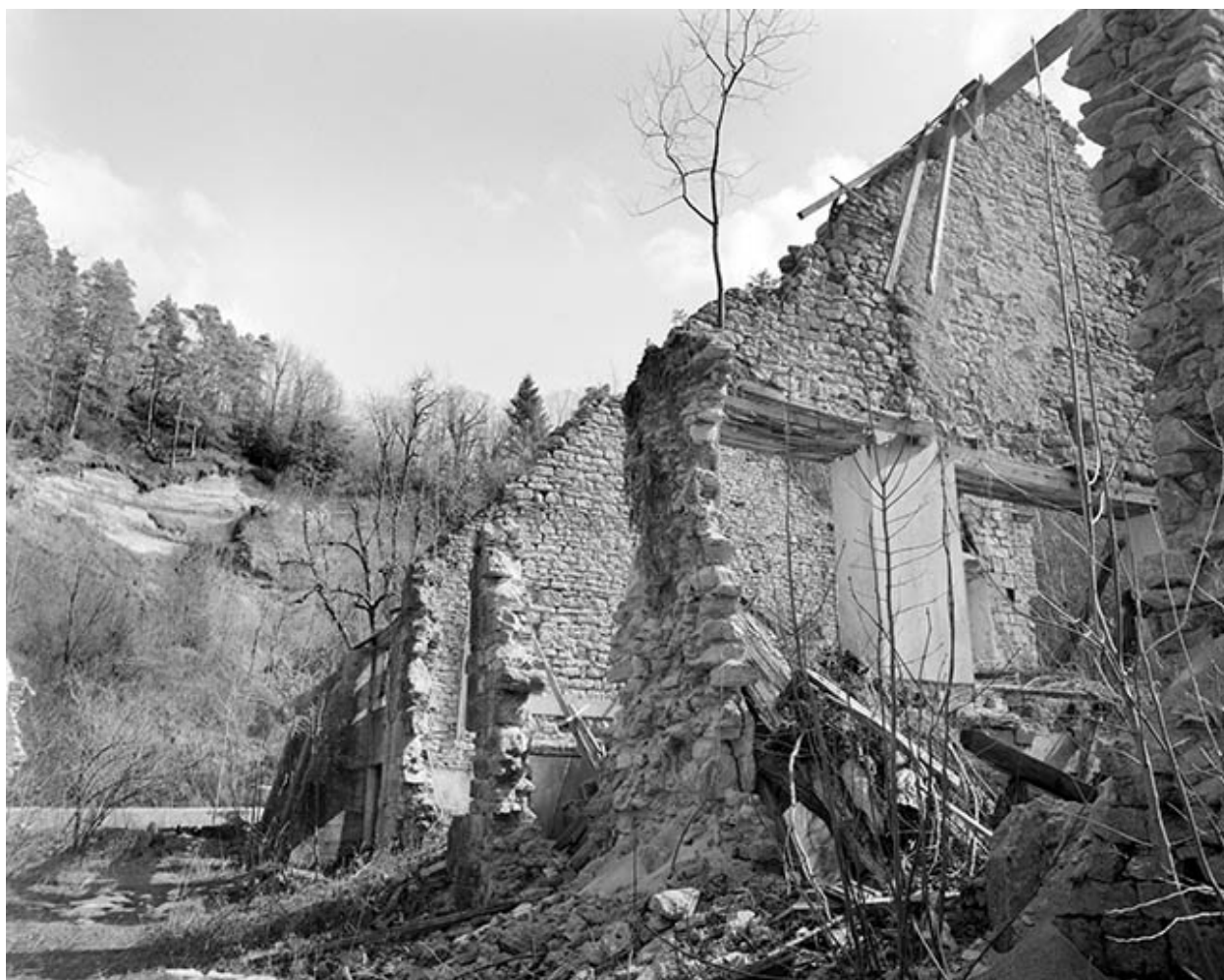
Murs de refend du logement patronal.
