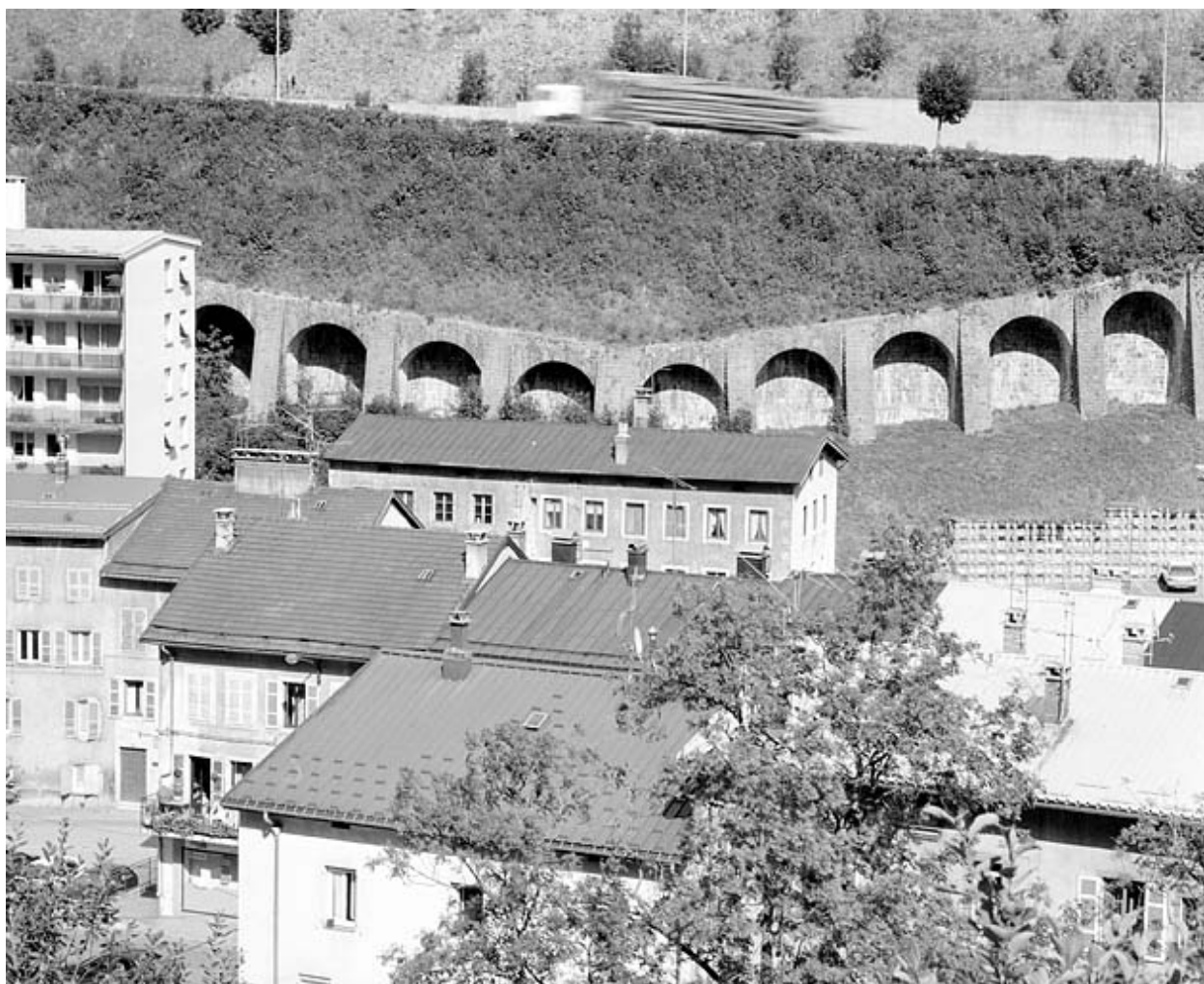
Mur à arcades, depuis l'ouest.
