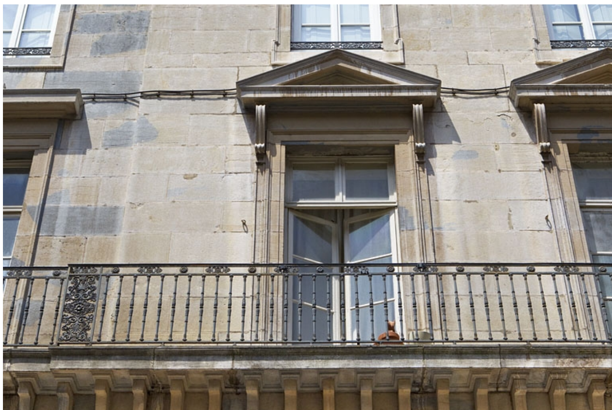
Façade antérieure : détail du balcon.
