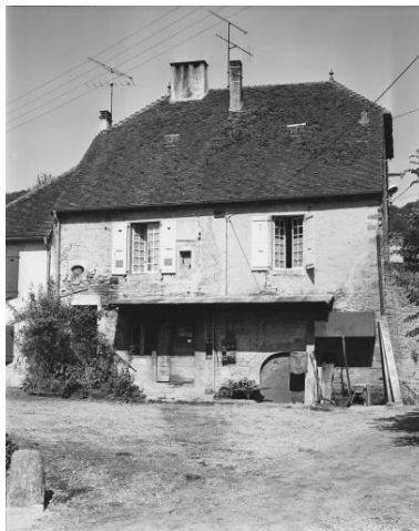
Façade antérieure. Phot. Dominique Dominguez IVR43_19803900036X
