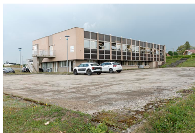
Façades postérieure et latérale droite.
