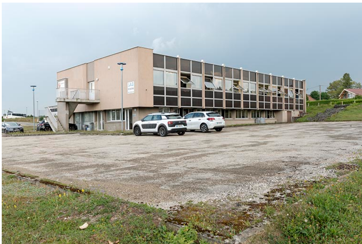
Façades postérieure et latérale droite.
