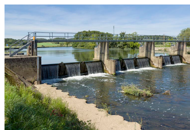
Le barrage à clapets. Phot. Sonia Dourlot IVR43_20157001519NUC2A
