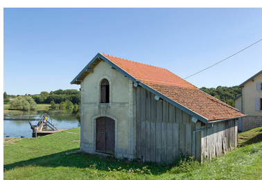
Magasin à aiguilles du barrage. Phot. Sonia Dourlot IVR43_20157001517NUC2A
