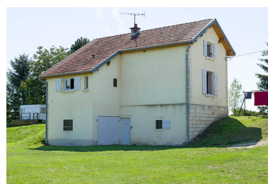
Façade postérieure de la maison. Phot. Sonia Dourlot IVR43_20157001515NUC2A
