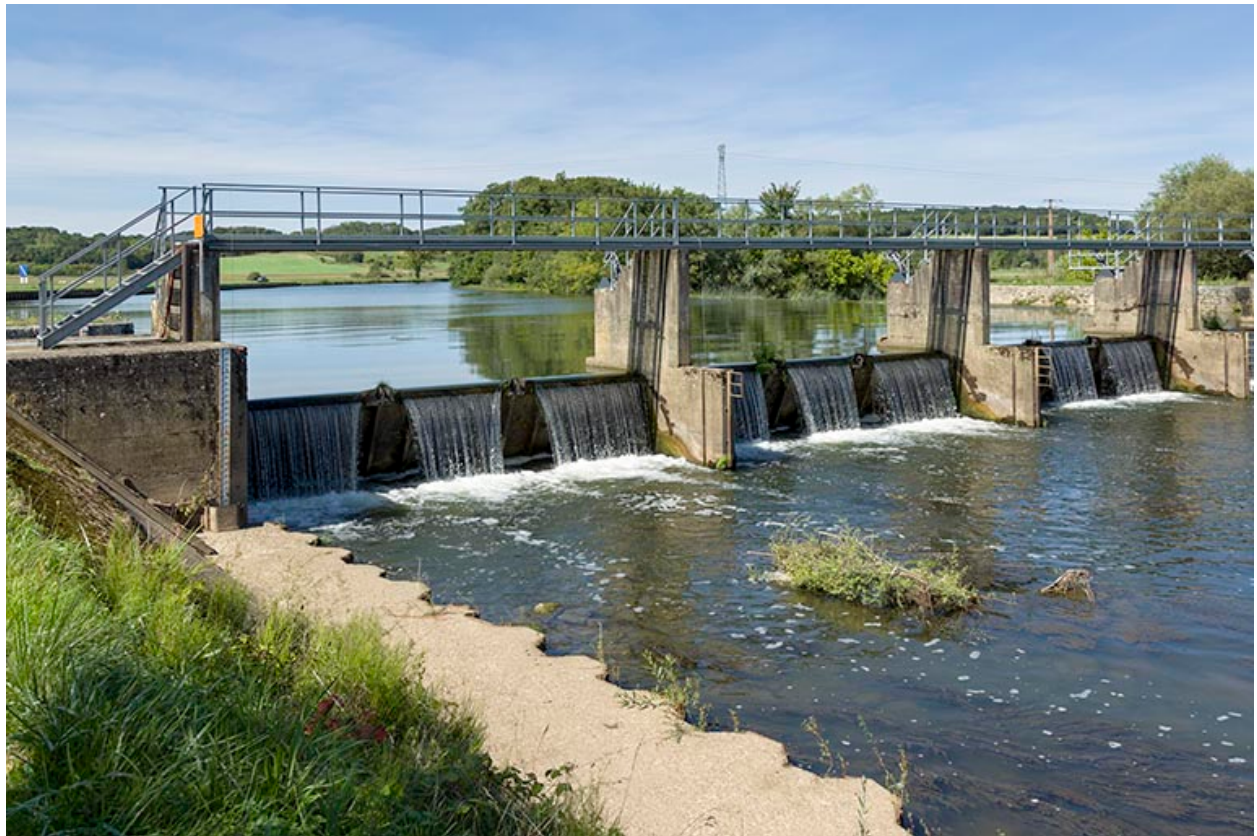
Le barrage à clapets.
