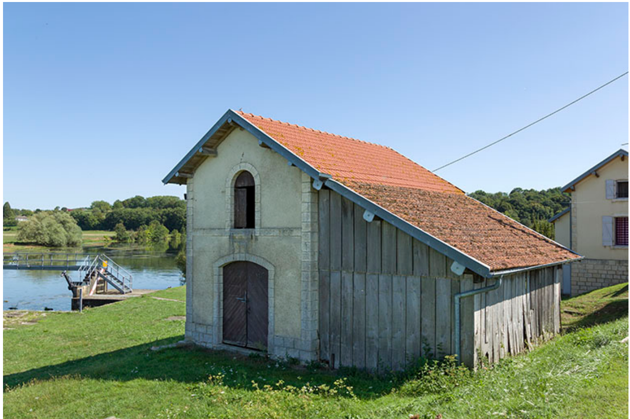
Magasin à aiguilles du barrage.
