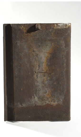
Tuile plate : face inférieure. Phot. Yves Sancey IVR43_20093900011NUC2A
