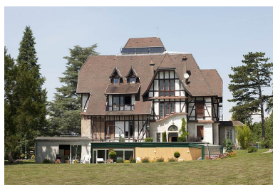
Façade sud depuis le parc. Phot. Jérôme Mongreville IVR43_20112501252NUC4A
