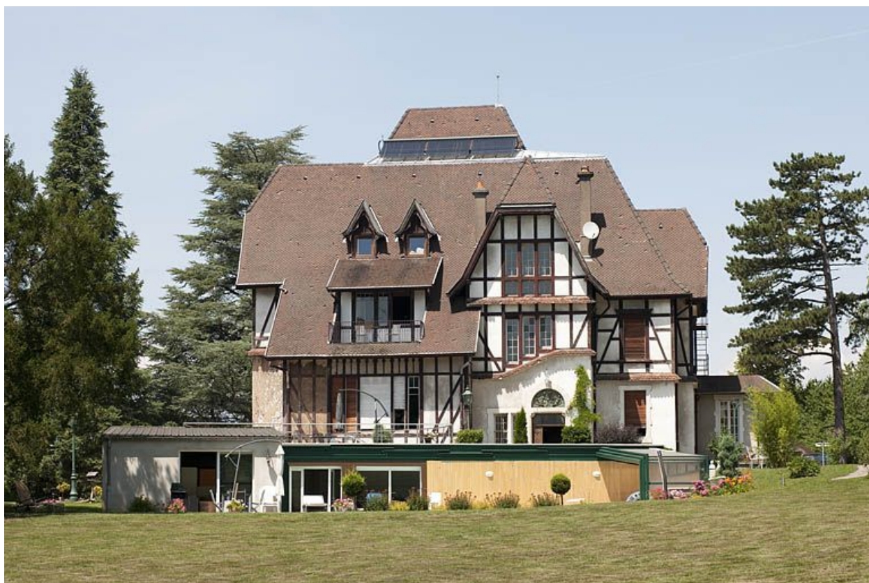
Façade sud depuis le parc.
