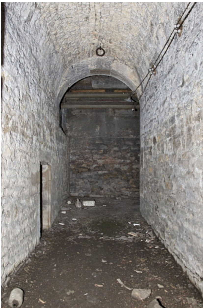
Sous-sol : détail d'un couloir voûté en berceau.
