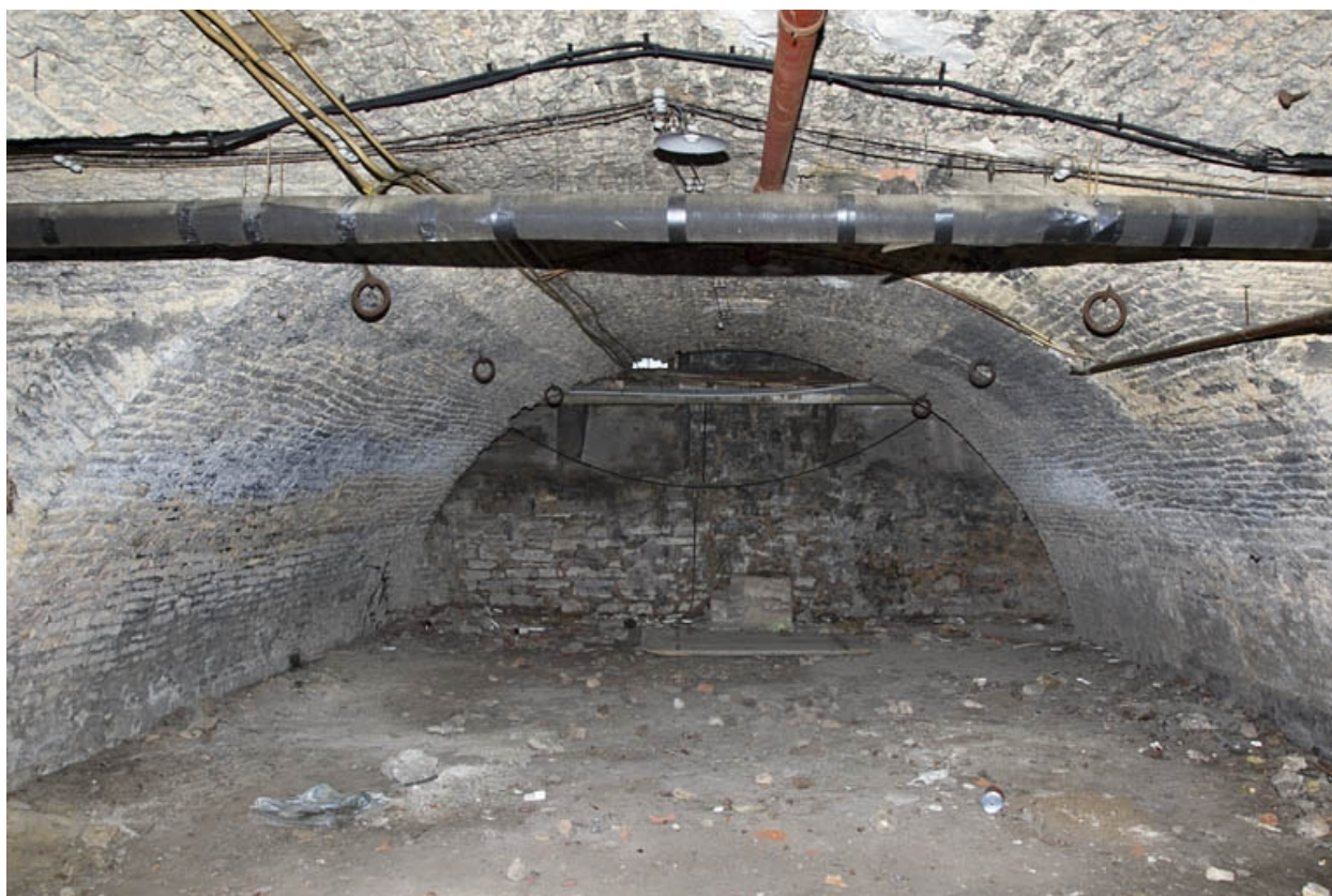
Sous-sol : détail d'une cave voûtée en berceau.
