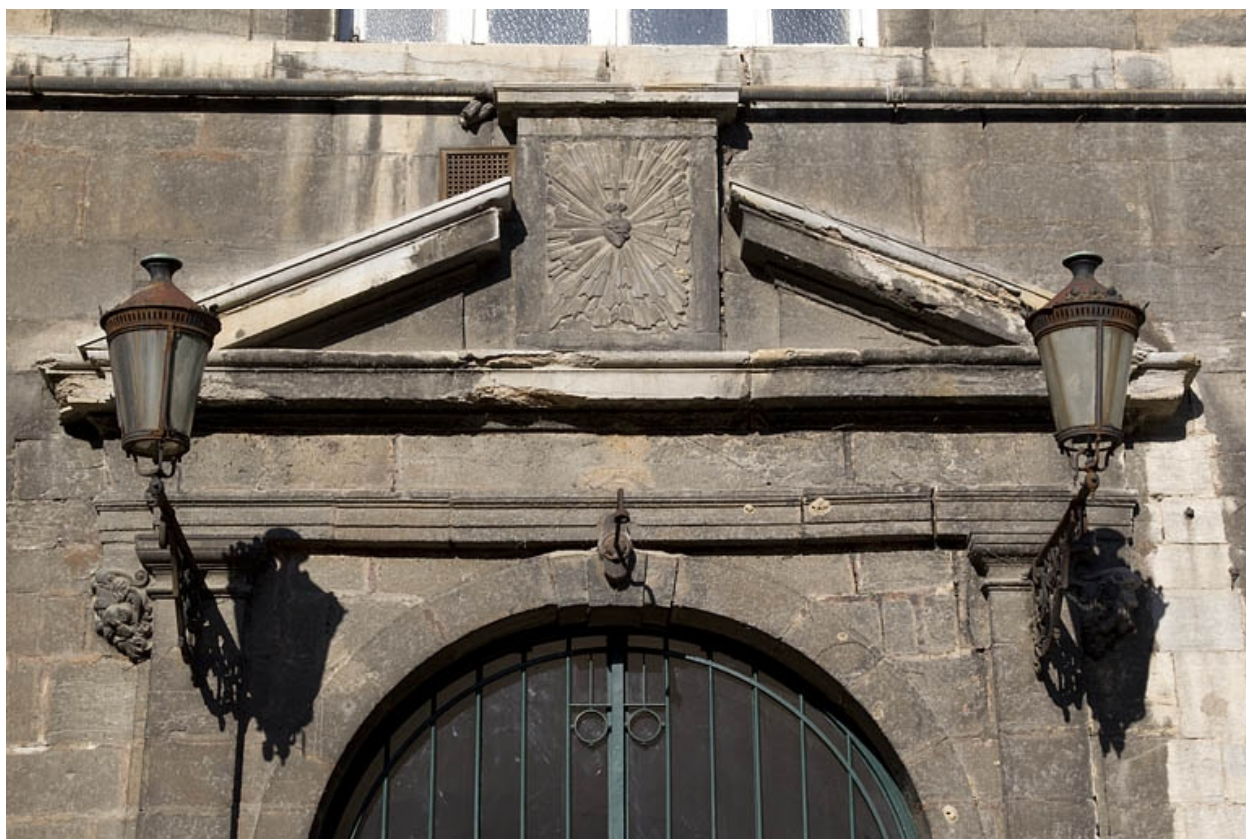
Façade antérieure, portail d'entrée : détail du fronton.
