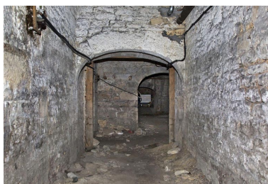
Sous-sol : détail d'un passage.
