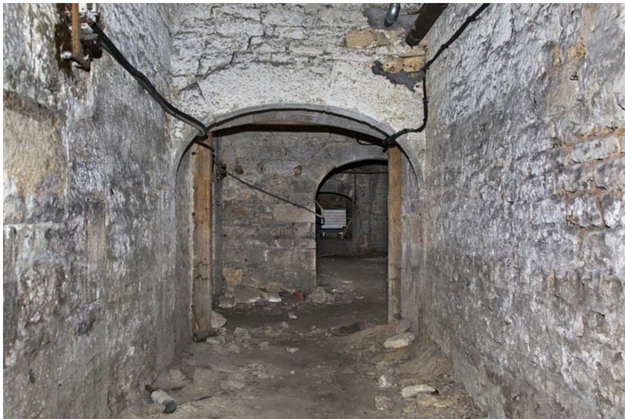
Sous-sol : détail d'un passage.
