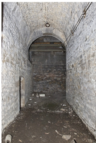
Sous-sol : détail d'un couloir voûté en berceau.
