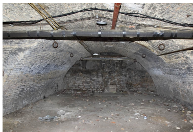
Sous-sol : détail d'une cave voûtée en berceau.
