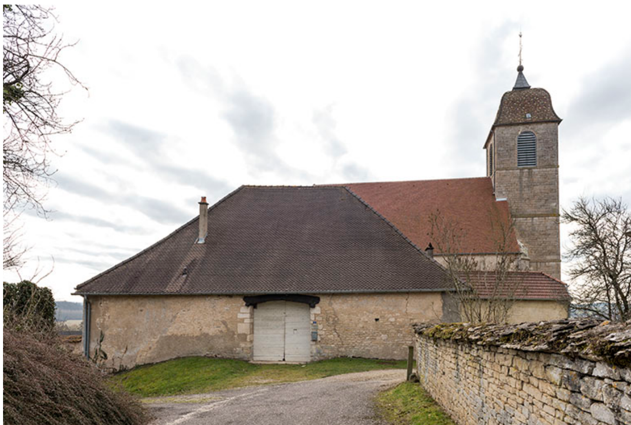
Vue générale depuis le chemin de la Vigne rouge.
