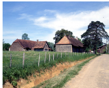
Vue d'ensemble depuis le sud en 1990. Phot. Yves Sancey IVR43_19903901120XA
