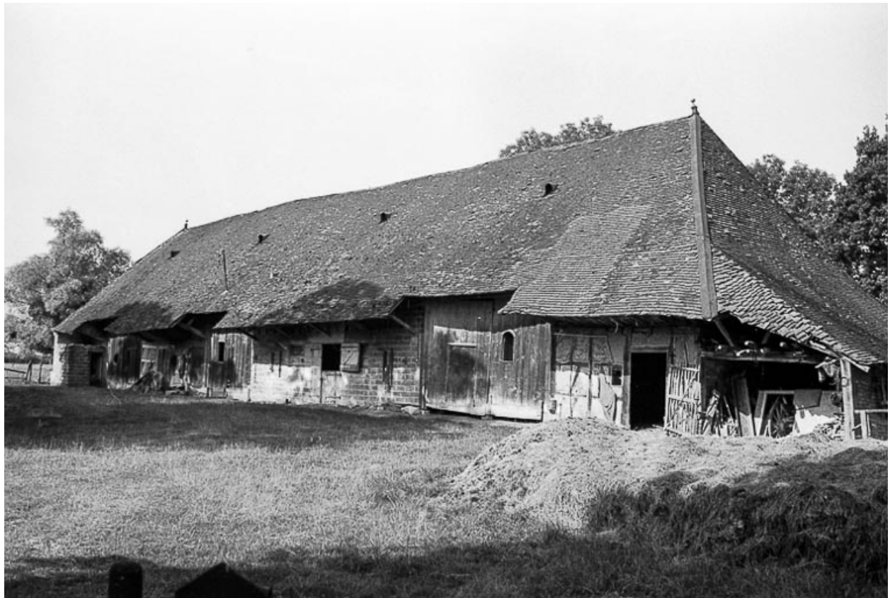
Façade postérieure en 1975.
