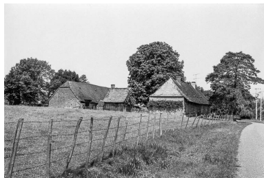
Vue d'ensemble depuis le sud en 1975. Phot. Guy Forestier IVR43_19753900083Z
