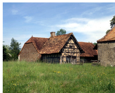
Le fournil en 1990. Phot. Yves Sancey IVR43_19903901121XA
