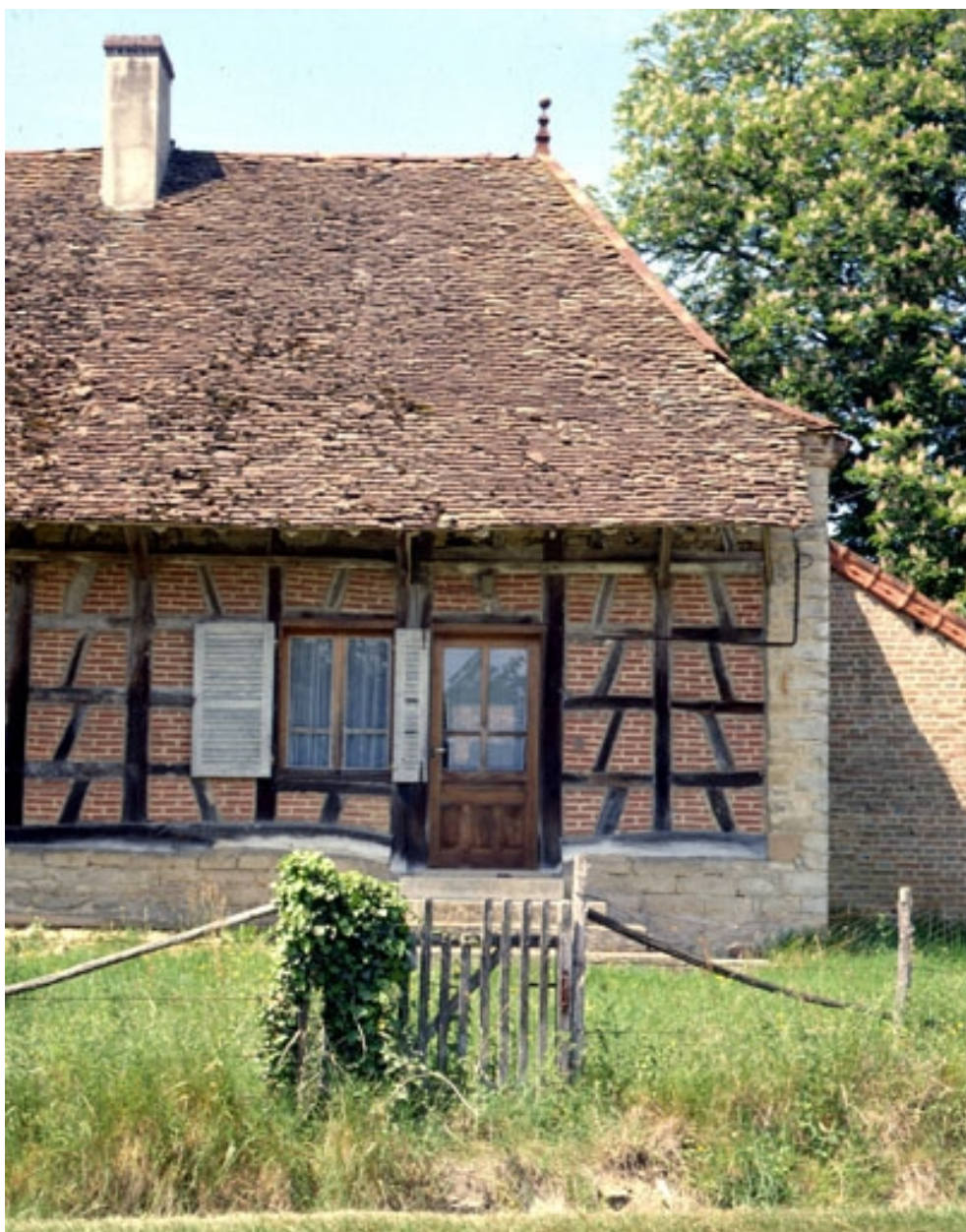
Bâtiment d'habitation en 1990 : partie droite.
