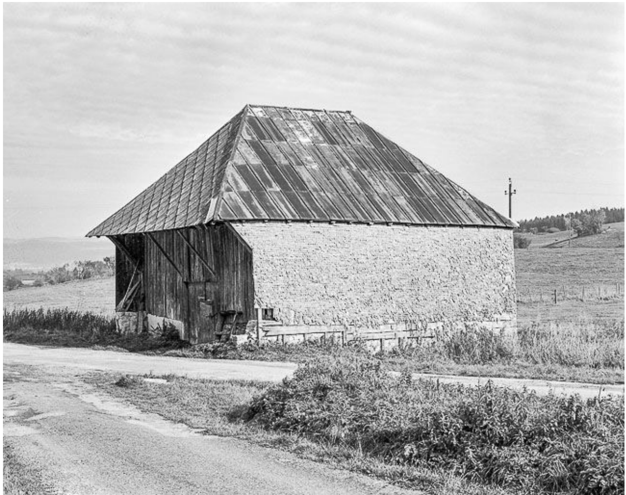
Bâtiment servant de remise.
