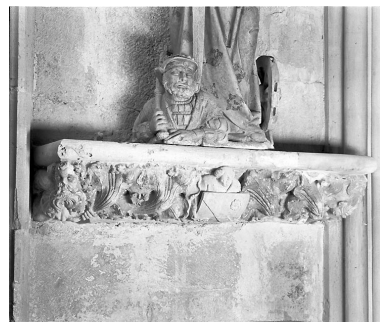
Grande console orientale : vue d'ensemble. Phot. Jérôme Mongreville IVR43_19903900819X
