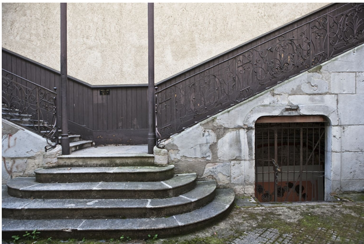
Escalier à cage ouverte sur cour : détail de l'emmarchement de l'escalier.
