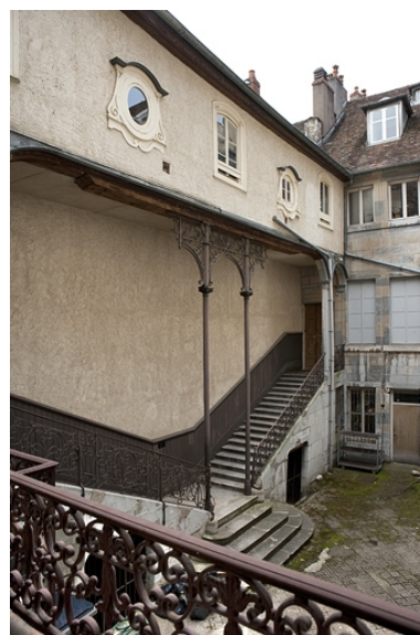
Escalier à cage ouverte
