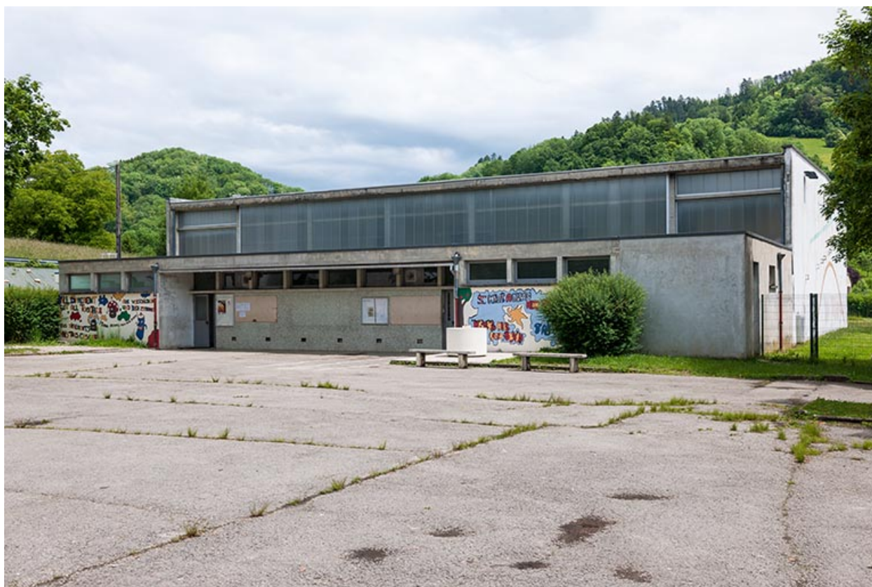
Façade antérieure du gymnase.
