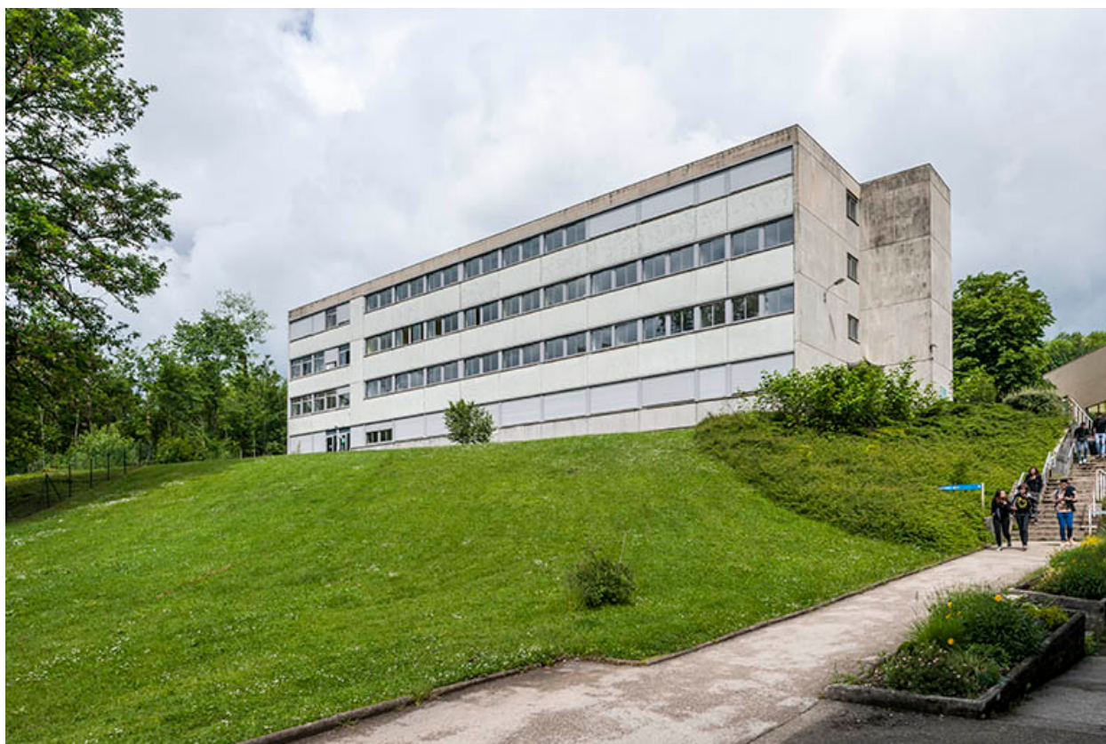
Façade sud de l'internat de garçons.
