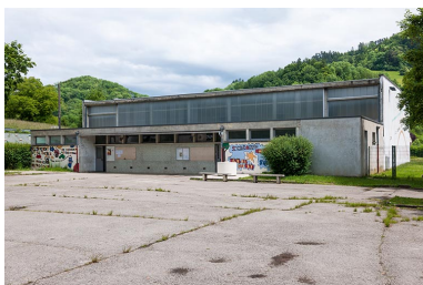
Façade antérieure du gymnase. Phot. Jérôme Mongreville IVR43_20143900077NUC4A
