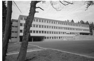
Façade antérieure de l'externat, s.d. [vers 1965]. Phot. Georges Chenu IVR43_20243901289NUC4A
