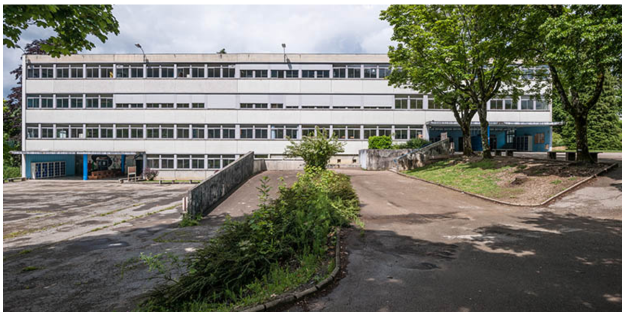
Cour et façade antérieure de l'externat.
