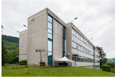
Angle nord-ouest de l'externat. Phot. Jérôme Mongreville IVR43_20143900062NUC4A
