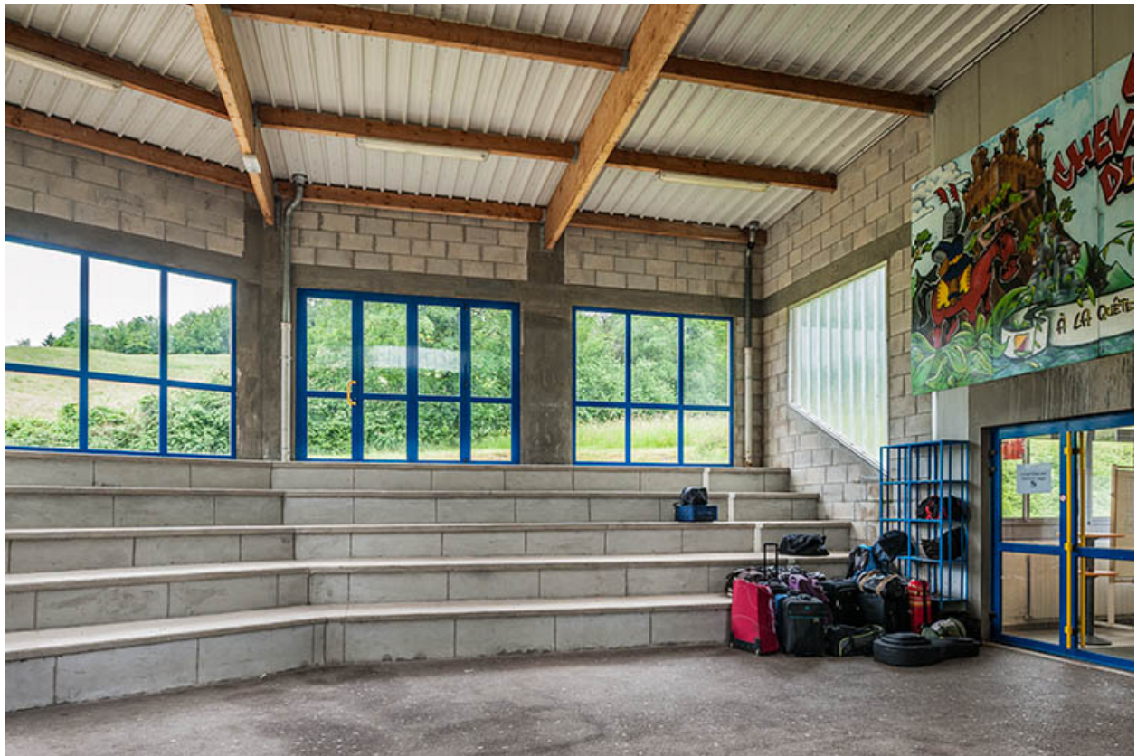
Préau de l'internat de filles.
