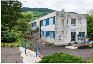
Angle nord-ouest de l'administration. Phot. Jérôme Mongreville IVR43_20143900058NUC4A
