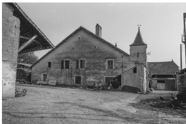
Habitation : façade latérale gauche. Phot. Bernard Lardière IVR43_19797000153Z
