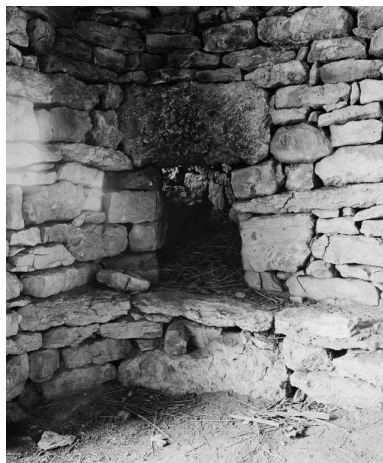
Vue de l'intérieur: détail du conduit de cheminée. Phot. Jean-Luc Duthu IVR26_19802100880X
