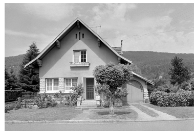
Maison reconstruite après guerre. Phot. Jérôme Mongreville IVR43_19973900888X
