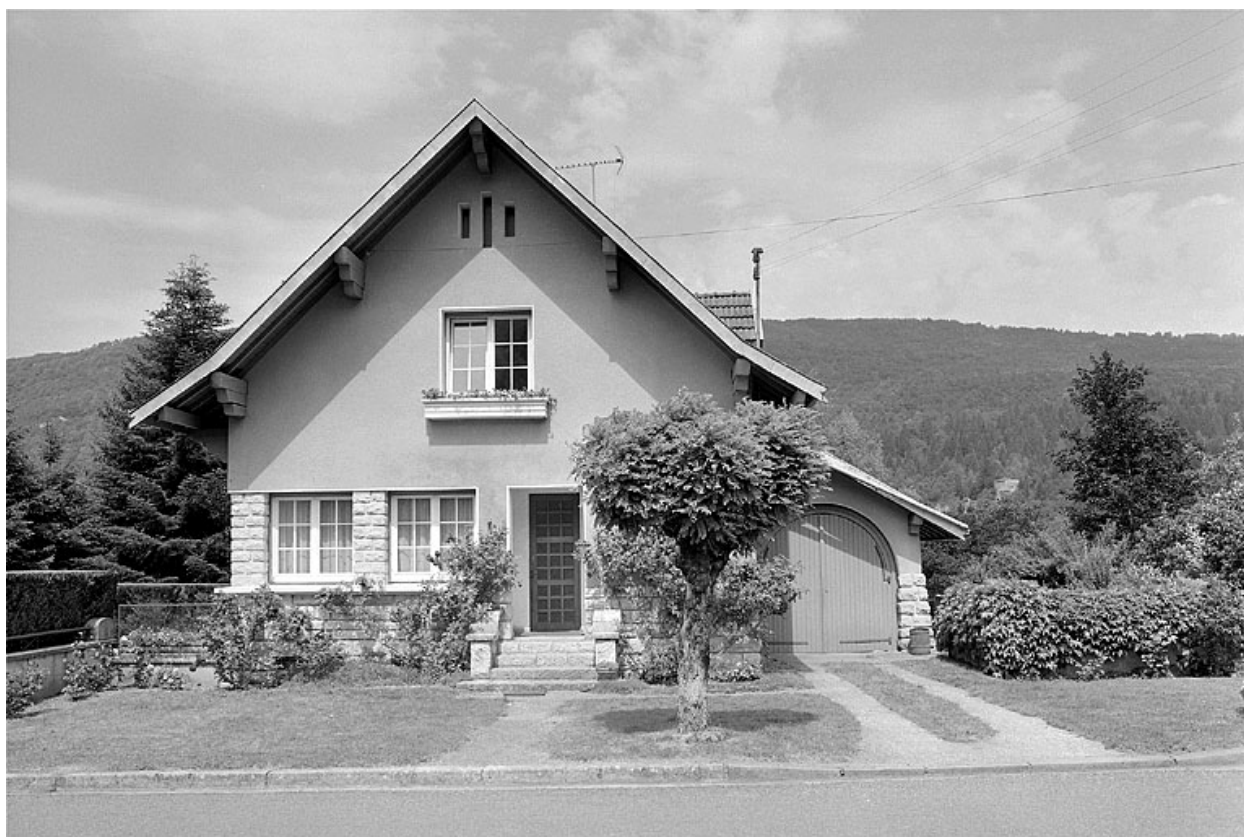
Maison reconstruite après guerre.
