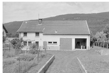
Ferme rue d'Epercy. Phot. Jérôme Mongreville IVR43_19973900890X
