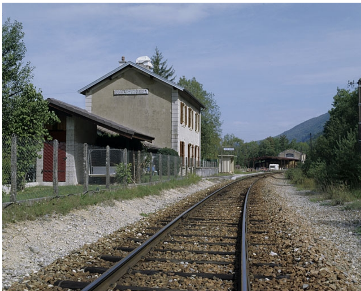
Gare de Dortan - Lavancia (voie ferrée Andelot - La Cluse).
