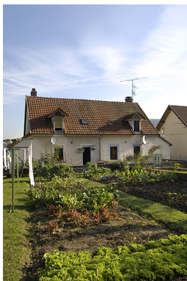
Façade sur jardin d'un logement ouvrier. Phot. Jérôme Mongreville IVR43_20057000508NUCA
