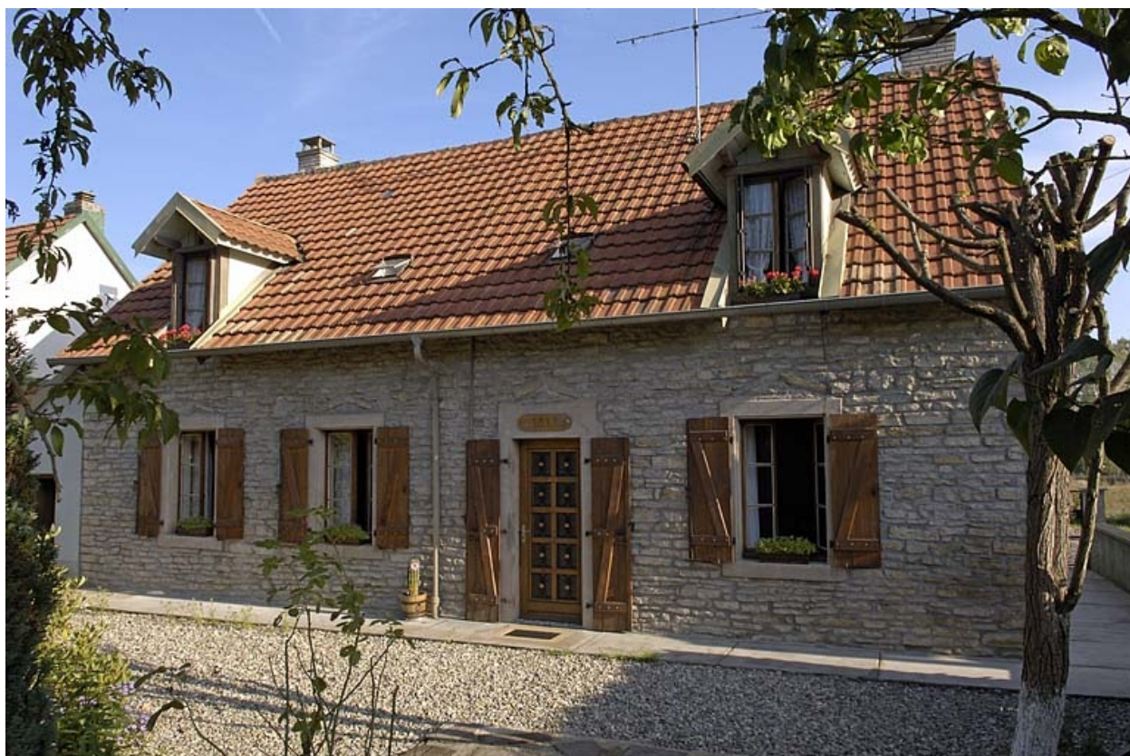
Façade postérieure d'un logement ouvrier.
