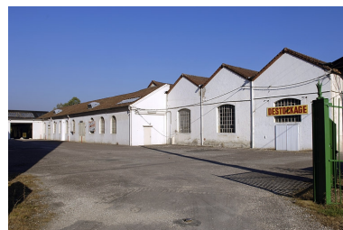
Façades sud de l'atelier de bobinage. Phot. Jérôme Mongreville IVR43_20057000501NUCA
