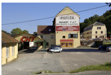
Ateliers de fabrication depuis l'ouest. Phot. Jérôme Mongreville IVR43_20057000511NUCA
