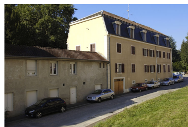
Ancien logement patronal. Phot. Jérôme Mongreville IVR43_20057000504NUCA
