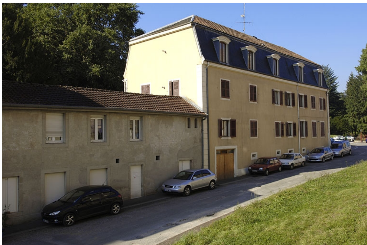
Ancien logement patronal.
