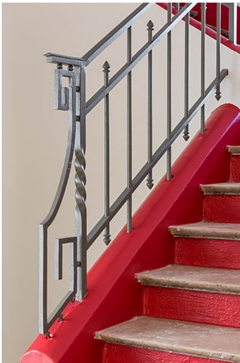
Vestibule : grille de l'escalier.
