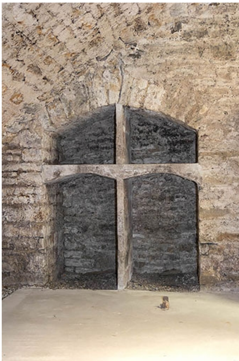
Cave : placard ménagé dans le mur.
