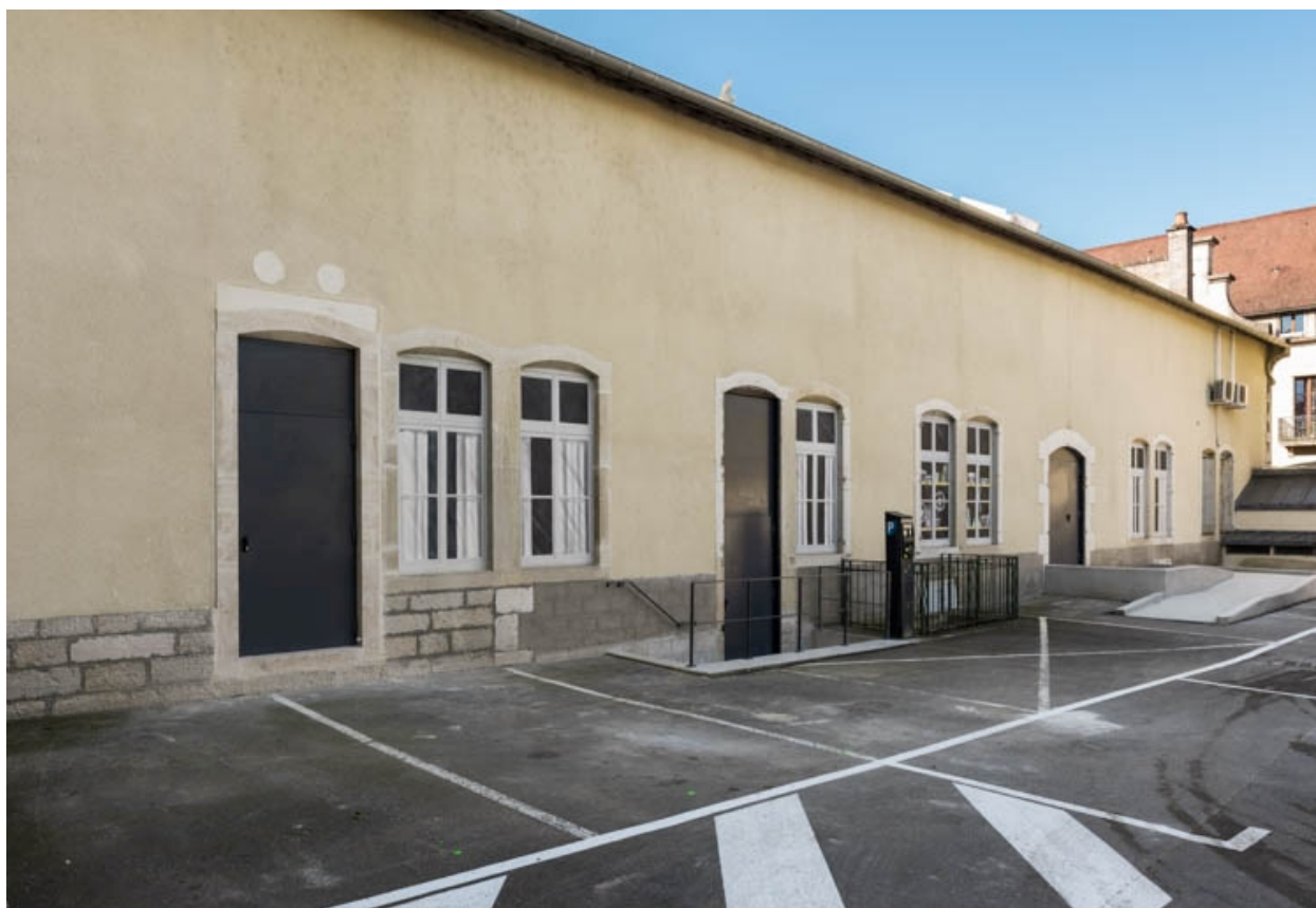
Façade latérale gauche, de trois quarts.
