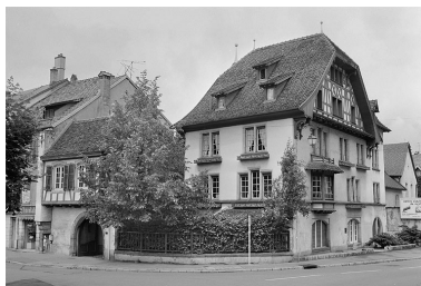
Vue d'ensemble. Phot. Jérôme Mongreville IVR43_19872500300X
