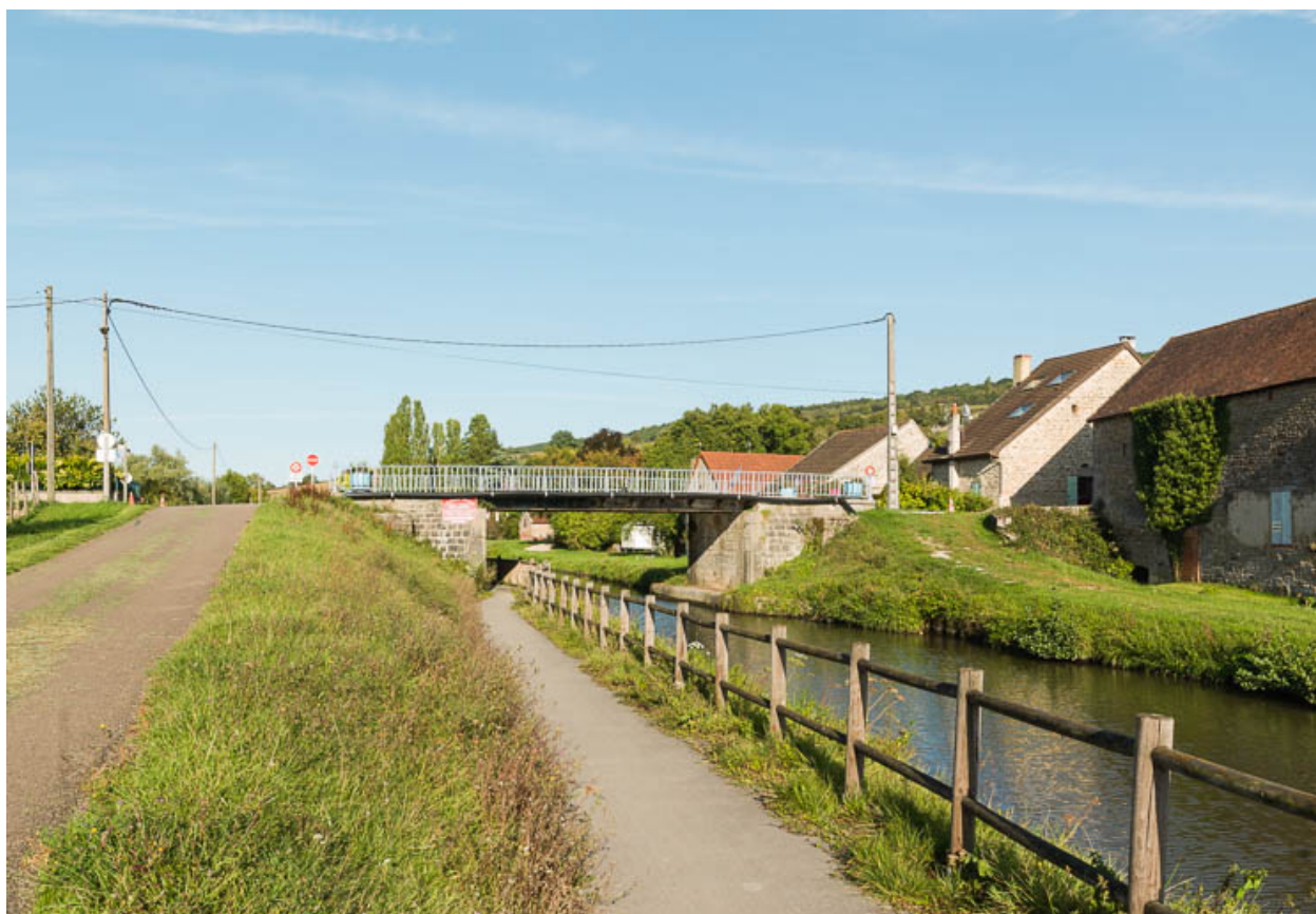
Vue d'ensemble du pont.
