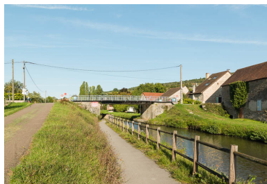
Vue d'ensemble du pont.
