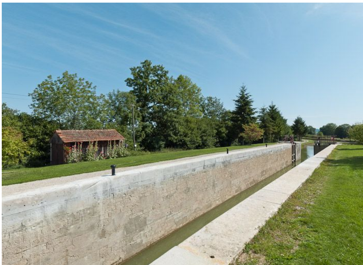
Vue du sas d'écluse.
