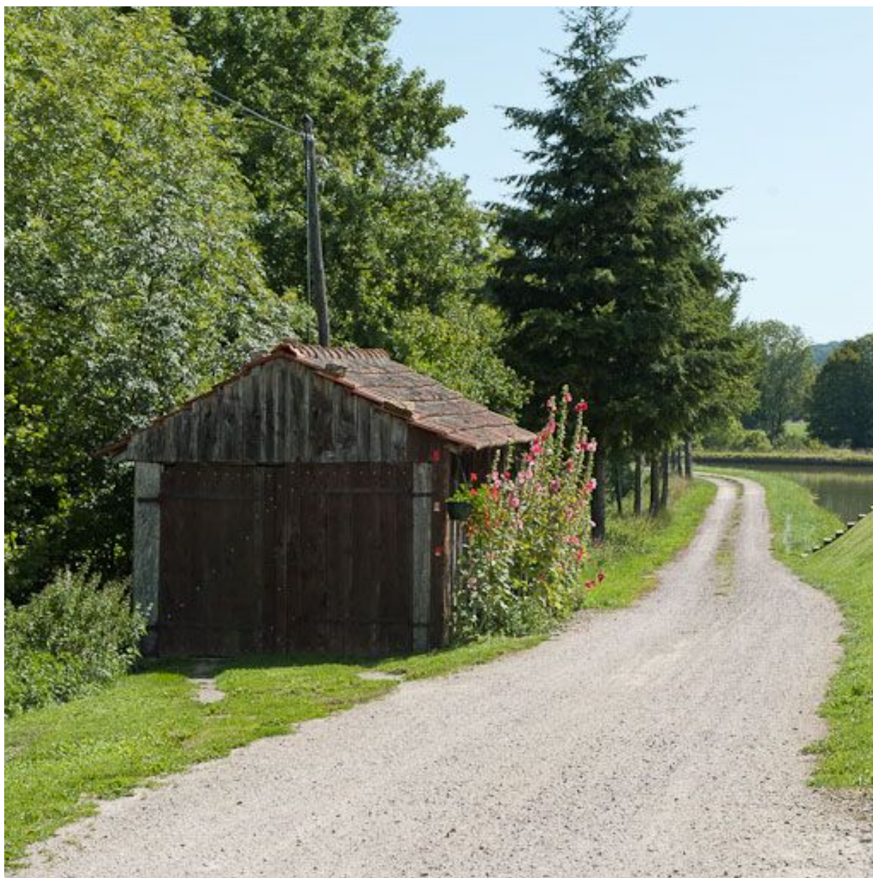
Vue de la remise en bois.
