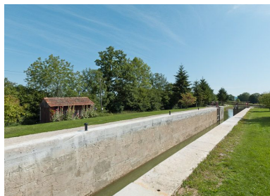
Vue du sas d'écluse.
