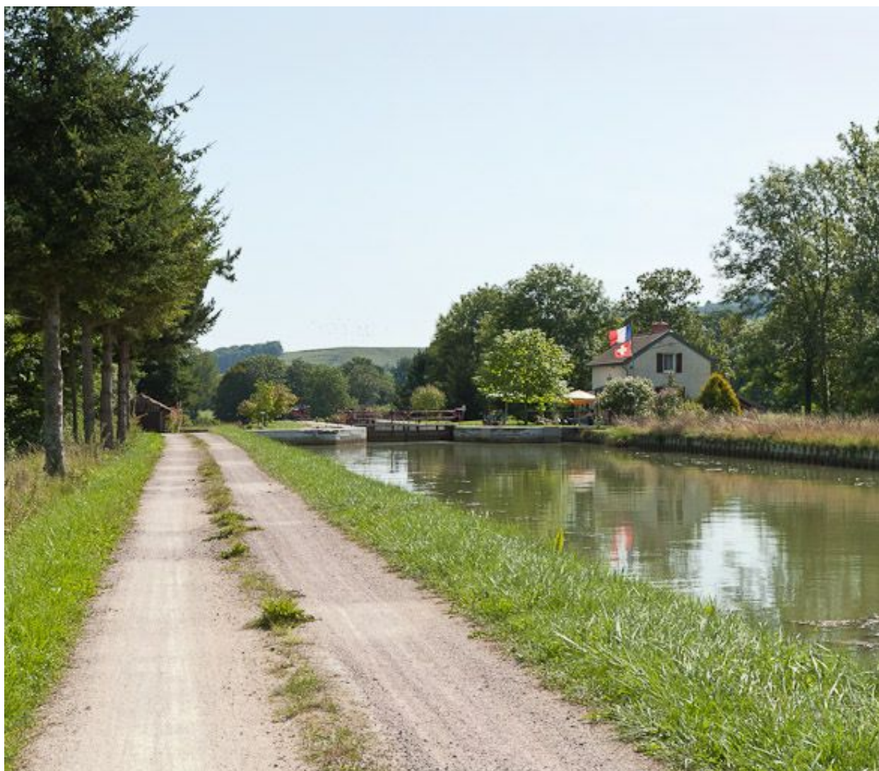
Vue du site d'écluse en amont.
