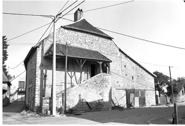
Façade avec l'escalier. Phot. Bernard Lardière IVR43_19767000443X
