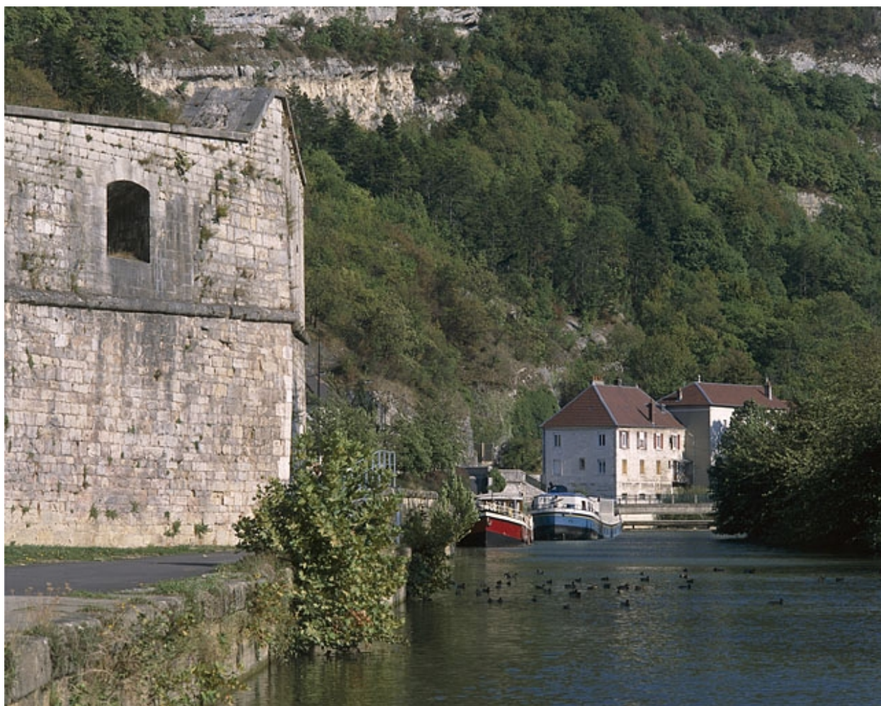
Vue d'ensemble, depuis l'amont.
