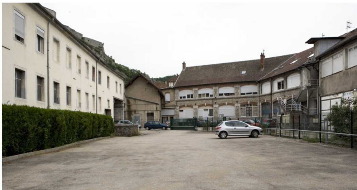
Cour, depuis l'amont.
