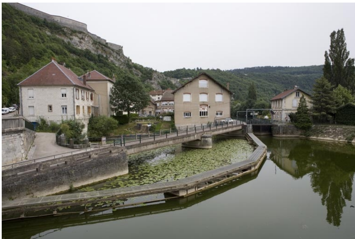
Façades amont (au nord-ouest).
