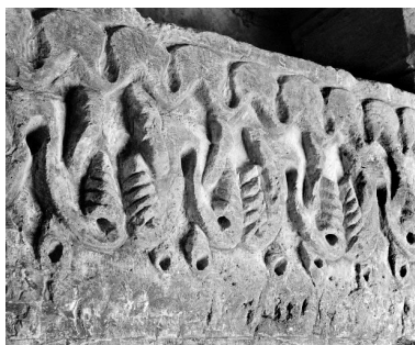
Détail. Phot. Yves Sancey IVR43_19829000276X
