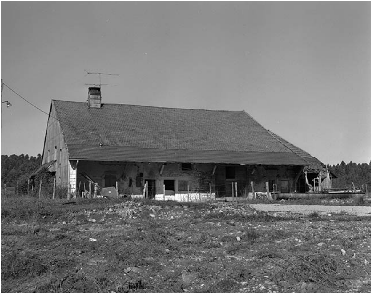
Façade latérale droite.
