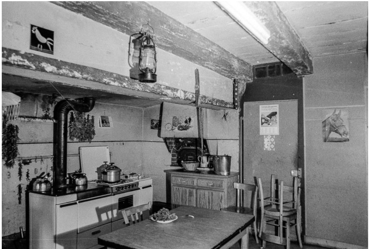
Cuisine : poutre supportant la cheminée.
