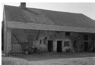
Façade latérale droite. Phot. Gilbert Poinot
