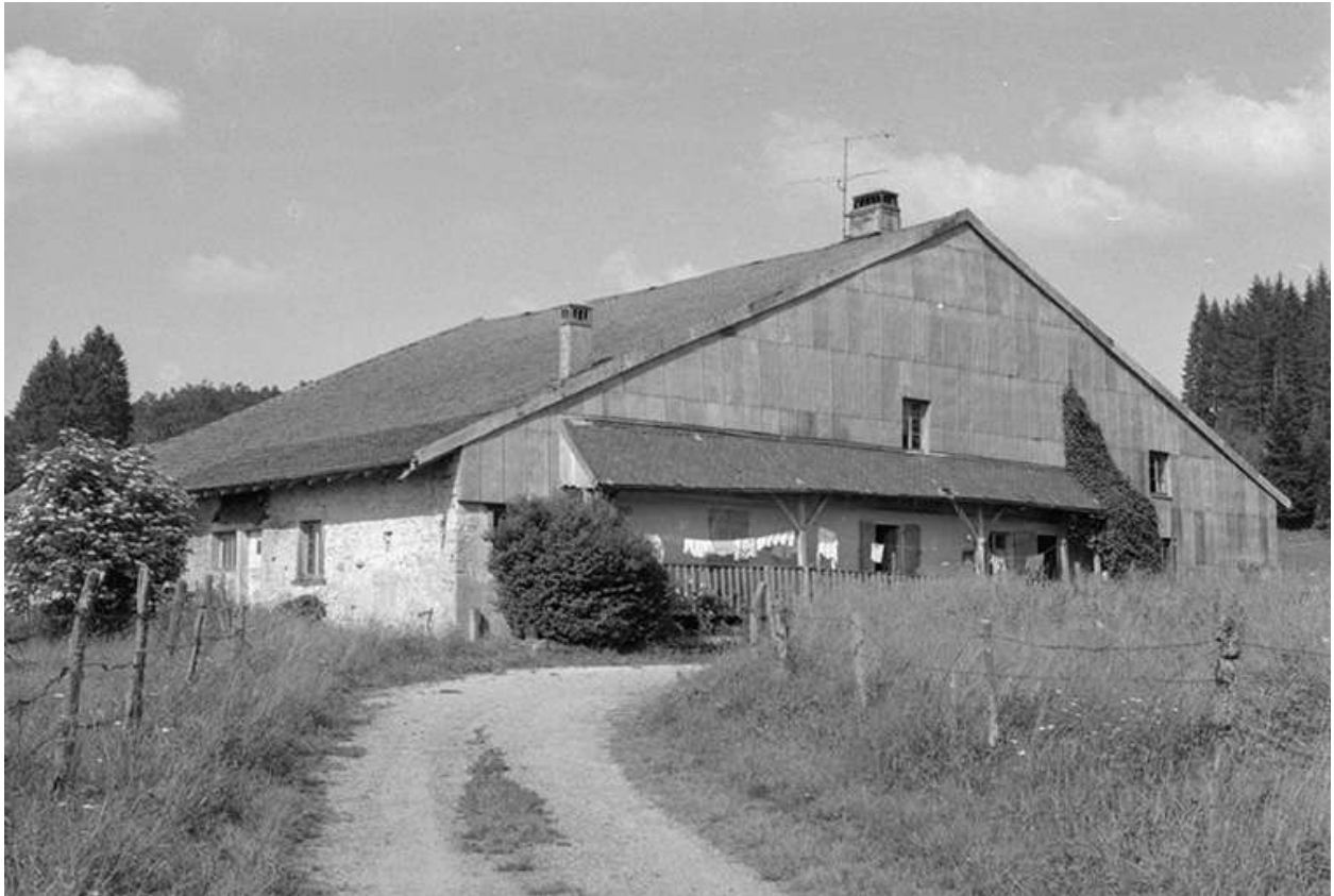
Façades antérieure et latérale gauche.
