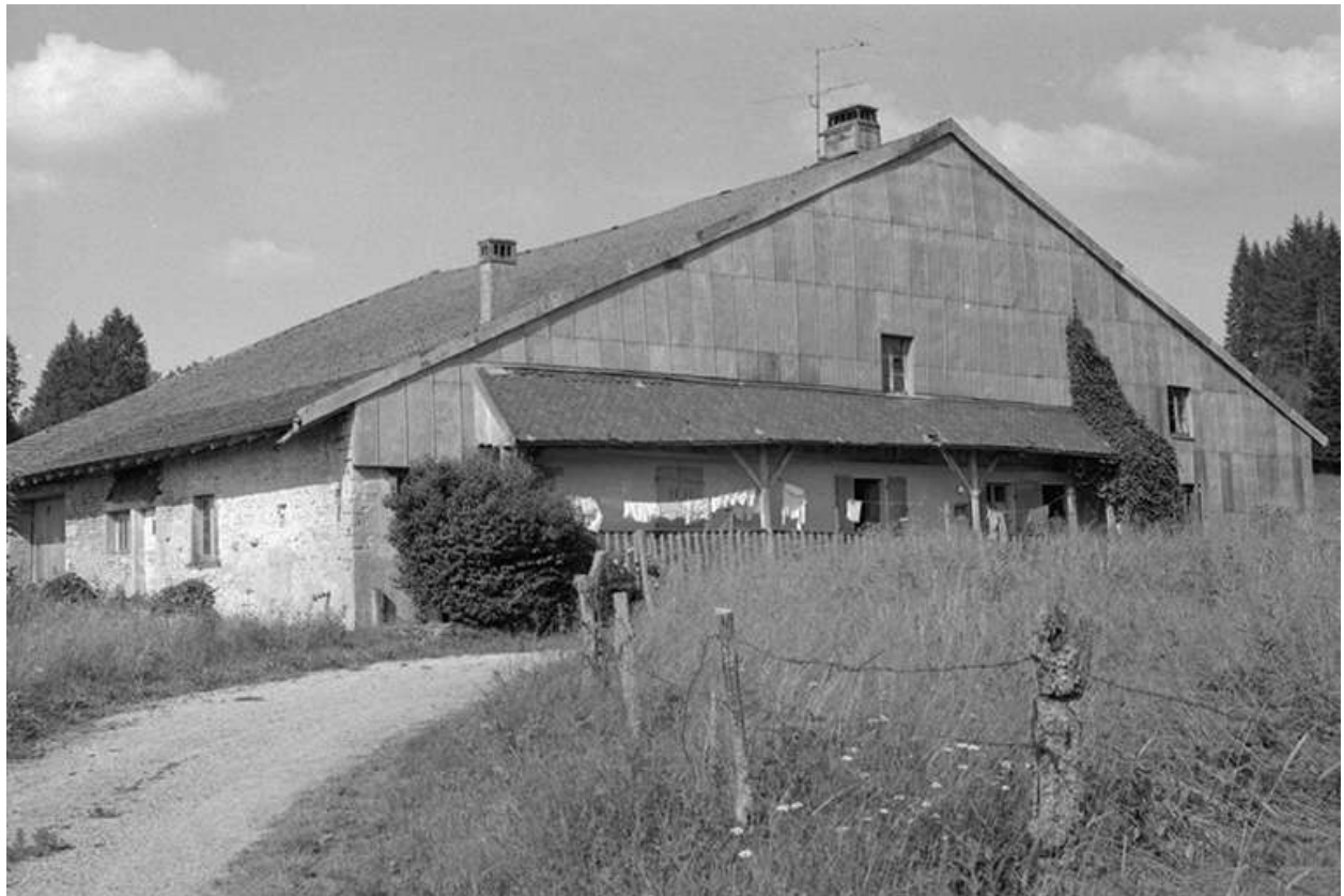
Façades antérieure et latérale gauche.
