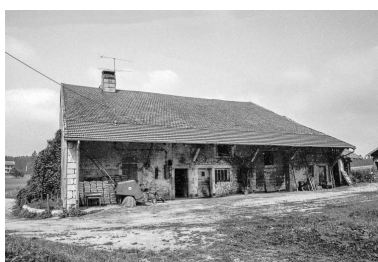
Façade latérale droite. Phot. Gilbert Poinot
