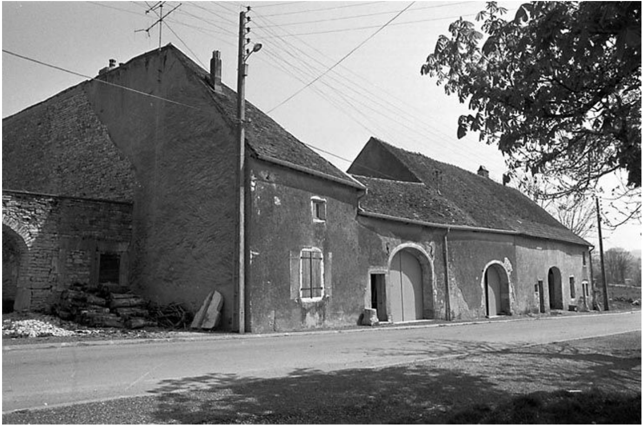
Ferme située 12 rue de Bucey-lès-By.
