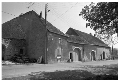
Ferme située 12 rue de Bucey-lès-By.
