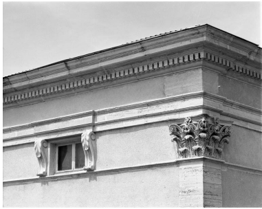
Façade antérieure : détail de l'attique.
