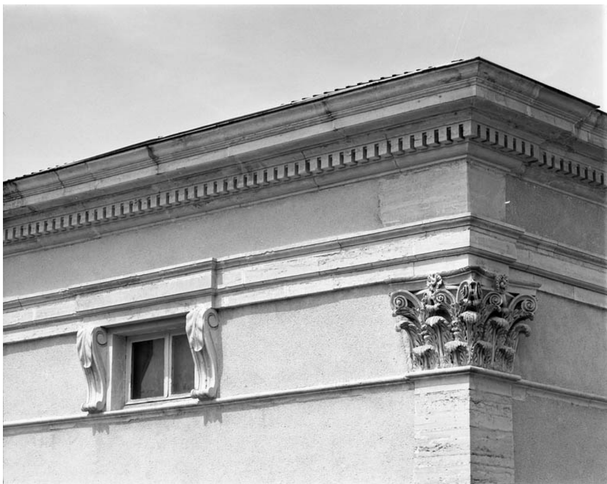
Façade antérieure : détail de l'attique.
