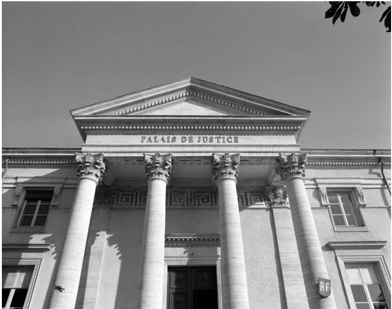
Façade antérieure : avant-corps central de face.
