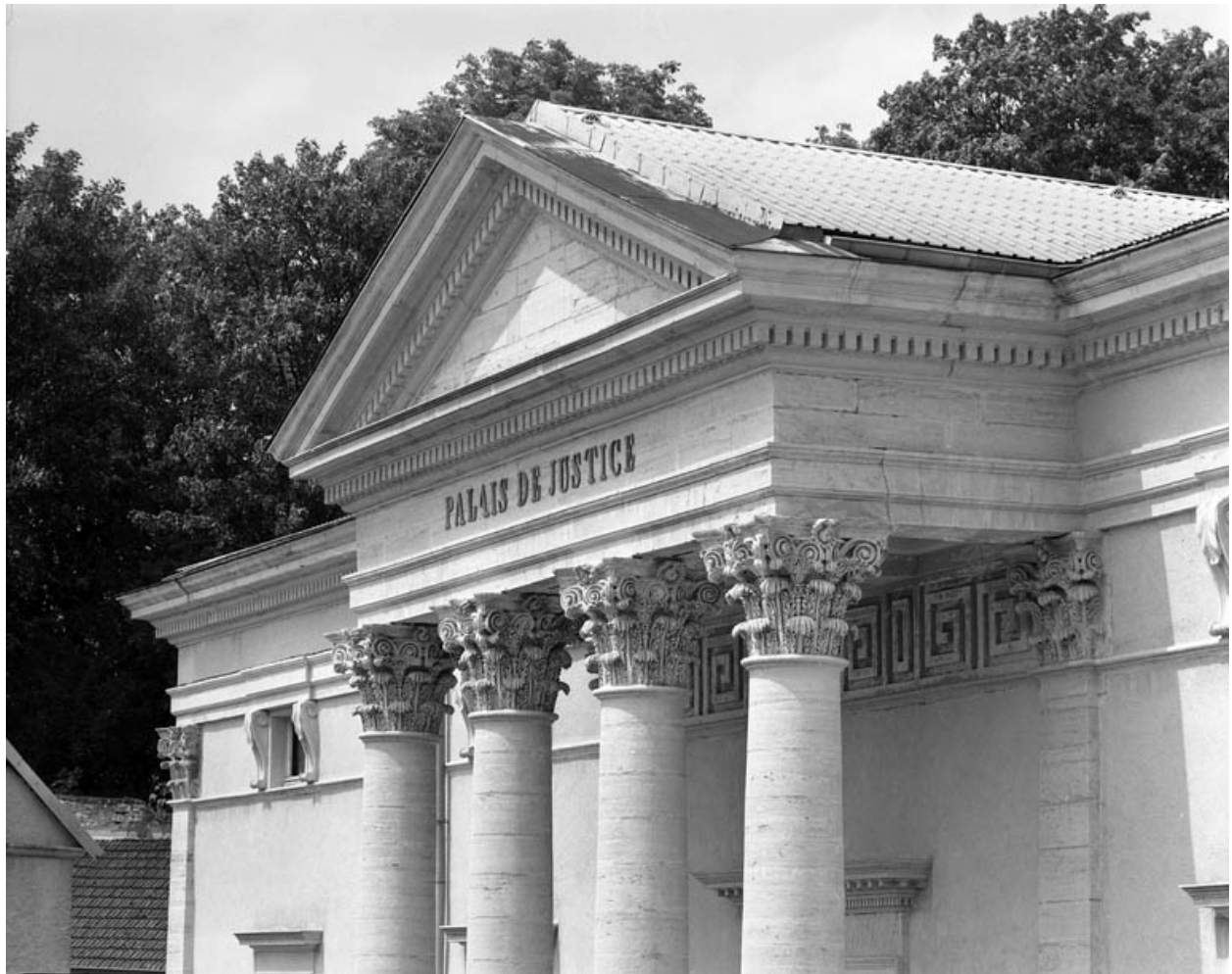
Façade antérieure : avant-corps central, détail du fronton.
