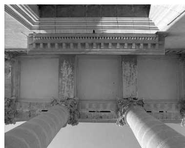
Façade antérieure : plafond de l'avant-corps central. Phot. Yves Sancey IVR43_19897000463X
