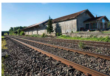
L'entrepôt de l'ancienne gare de Port-sur-Saône. Phot. Jérôme Mongreville IVR43_20177001005NUC4A
